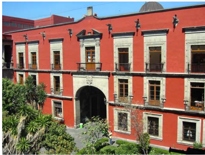
Foto 17 Visita interior del edificio que alberga al MNC. (Fuente: Vega, J. MNC).
