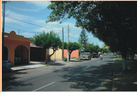
Líneas de energía eléctrica y telefonía vía aérea
