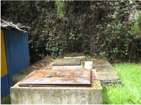
Vista exterior de la planta FS-02 Registro de aspirantes (público)
