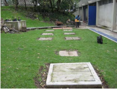
Vista exterior de la planta FS – 23 Gimnasio.
