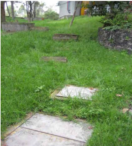
Vista exterior de la planta FS-11 Mesa vibradora
