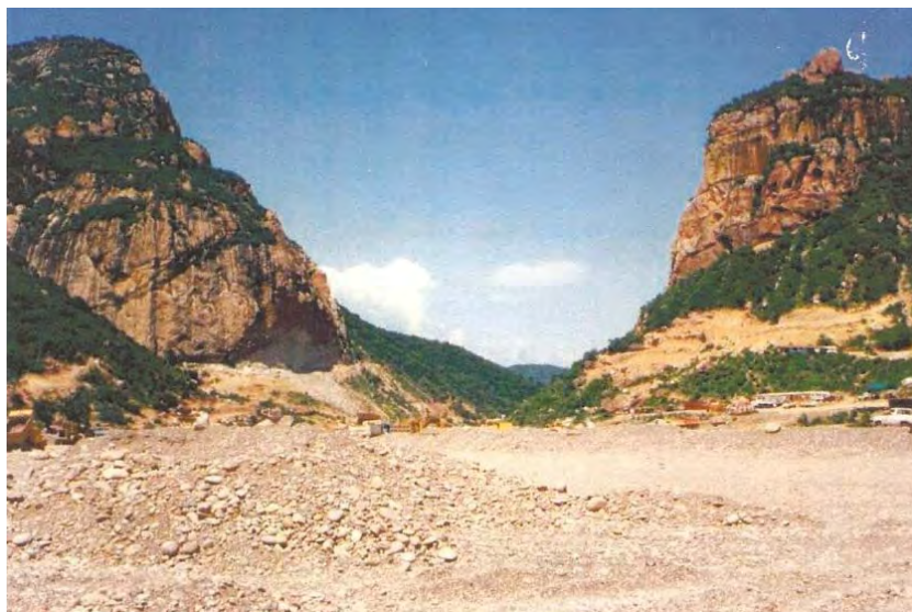
Figura 86. Presa “Huites”, vista del sitio desde aguas abajo antes del inicio de la obra (Hungsberg, 2001).
