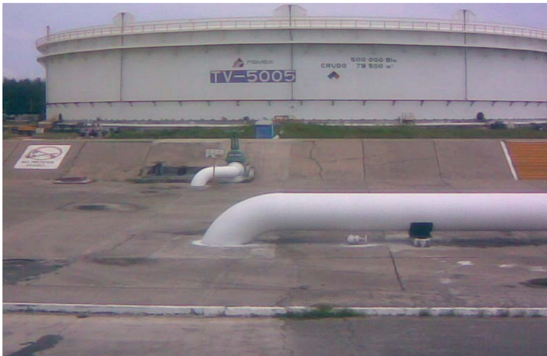
Fig. 6.4 Tanque de almacenamiento TV-5005.
