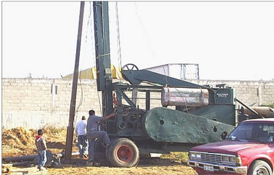
Figura 18. Perforación por Percusión
