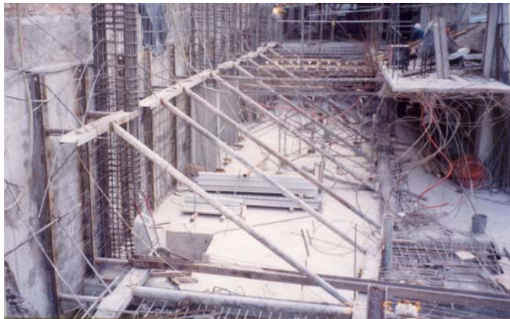
Fotos de viguetas y muro de concreto armado
