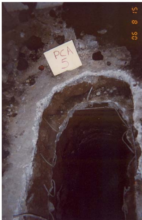
Fig.10 Fotos y perfiles de pozos a cielo abierto realizados
