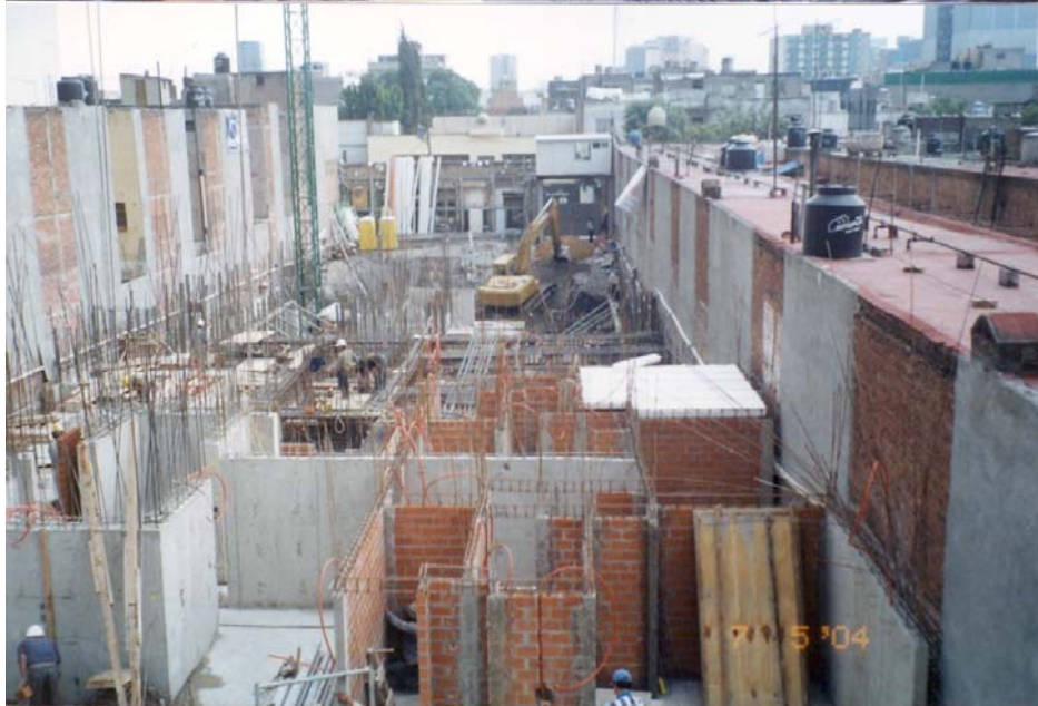
Foto proceso constructivo
