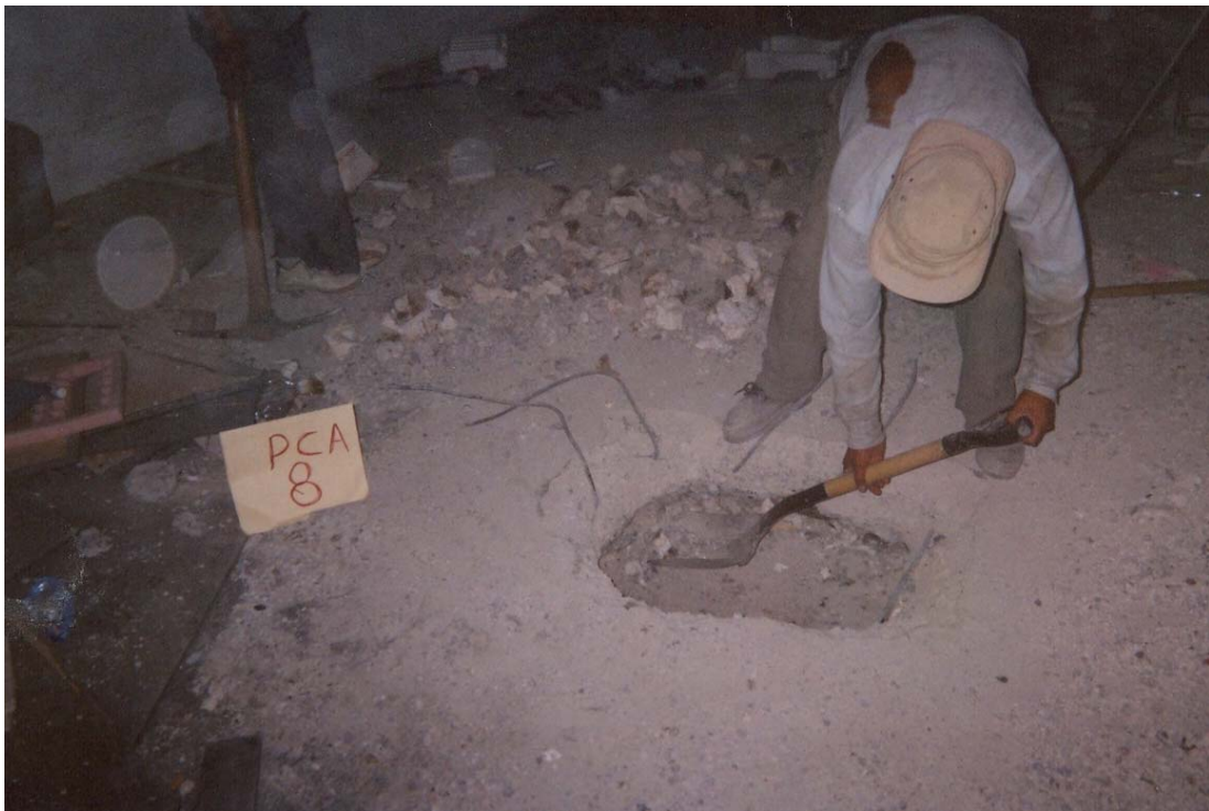
Fig.13 Fotos y perfiles de pozos a cielo abierto realizados
