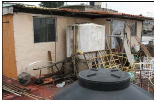
CUARTO DE SERVICIO EN AZOTEA
