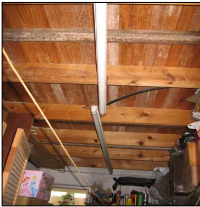
CUARTO DE LAVADO EN EL PRIMER PISO
