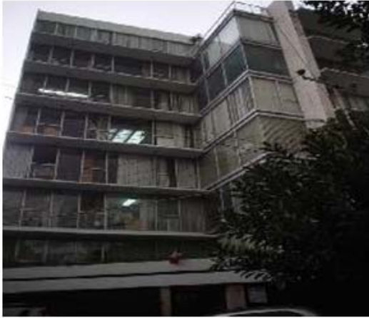
1.- VIADUCTO MIGUEL ALEMAN S/N COLONIA
