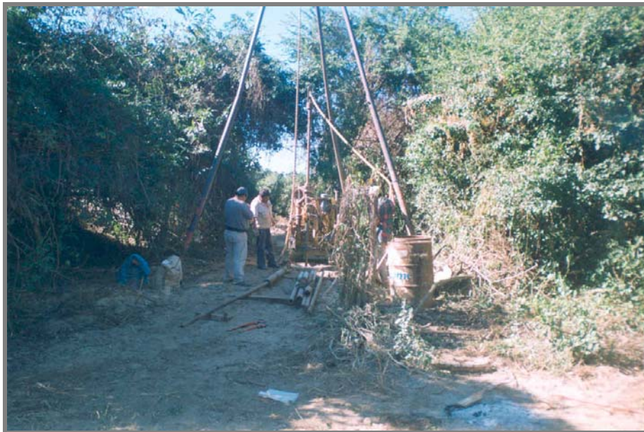
FOTO 2. OTRA VISTA DEL EQUIPO Y BRIGADA DE PERFORACION INSTALADOS EN EL SITIO DEL SONDEO SM-1, UBICADO EN EL KM 226+924.
