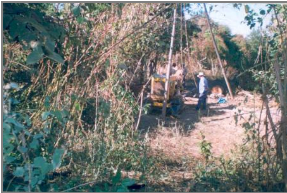
FOTO 4. OTRA VISTA DEL EQUIPO Y BRIGADA DE PERFORACION INSTALADOS EN EL SITIO DEL SONDEO SM-2, UBICADO EN EL KM 226+961.80
