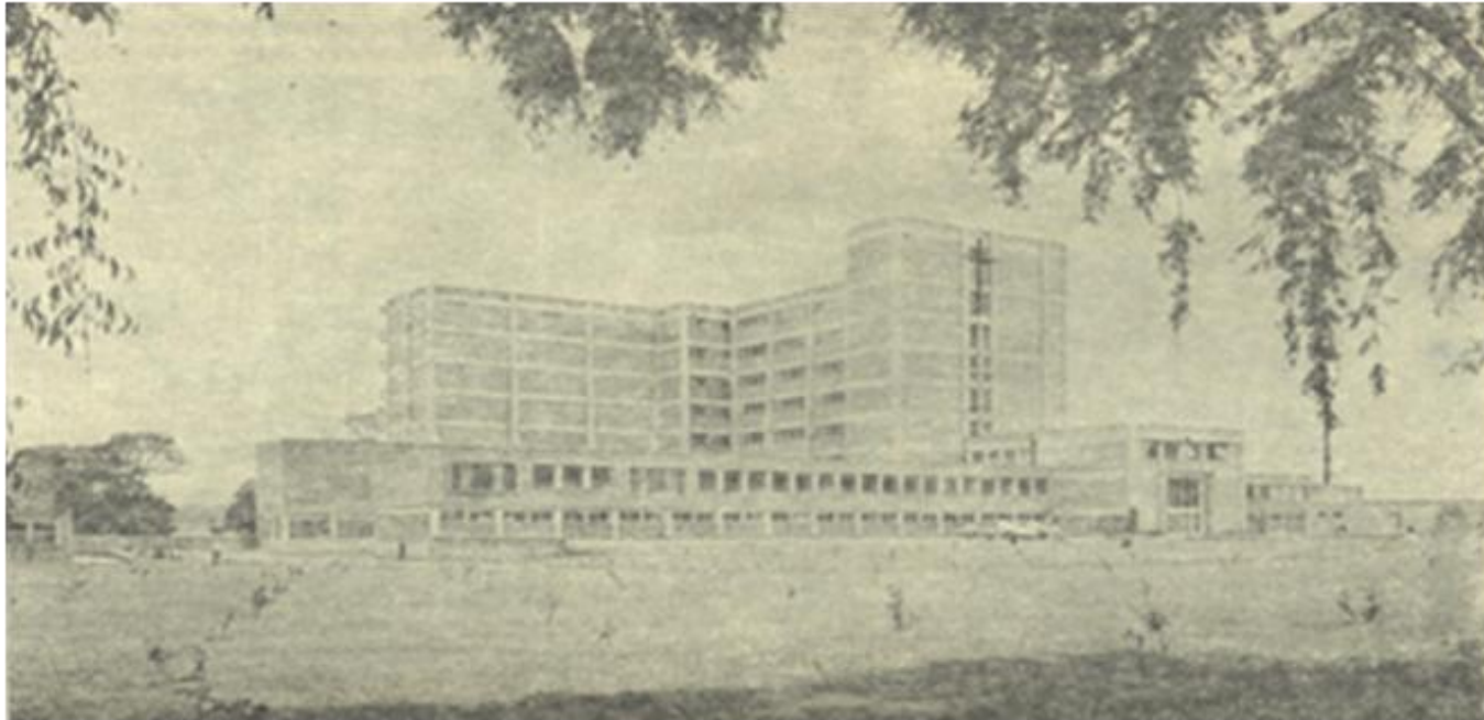
Hospital Antituberculoso Gea González, Huipulco Tlalpán, D.F., 1942. Actualmente modificado profundamente.
