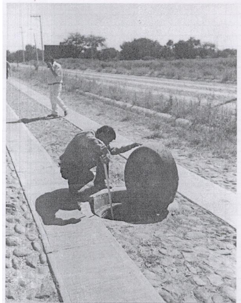
Verificación de Arrastre de Pozo de Visita sobre Av. El Tepeyac
