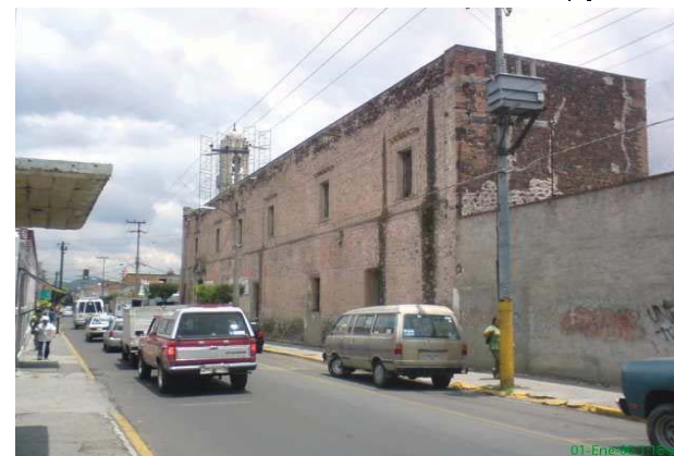
Fuente: Fotografía 2 de campo por autor de la tesis 2007 vista por calle 2 de marzo Texcoco edo. de México
