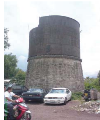
Fuente: Fotografía 7 de campo por autor de la tesis 2007 "Tanque elevado estacion de ferrocarriles" Texcoco edo. de México
