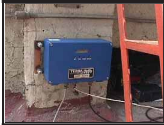
Figura 4.12. Instrumentación del Edificio Reforma 116
