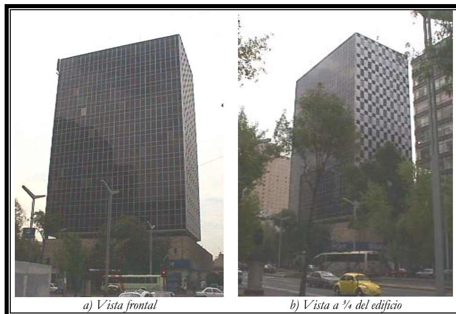
Figura 3.11. Imágenes del edificio
