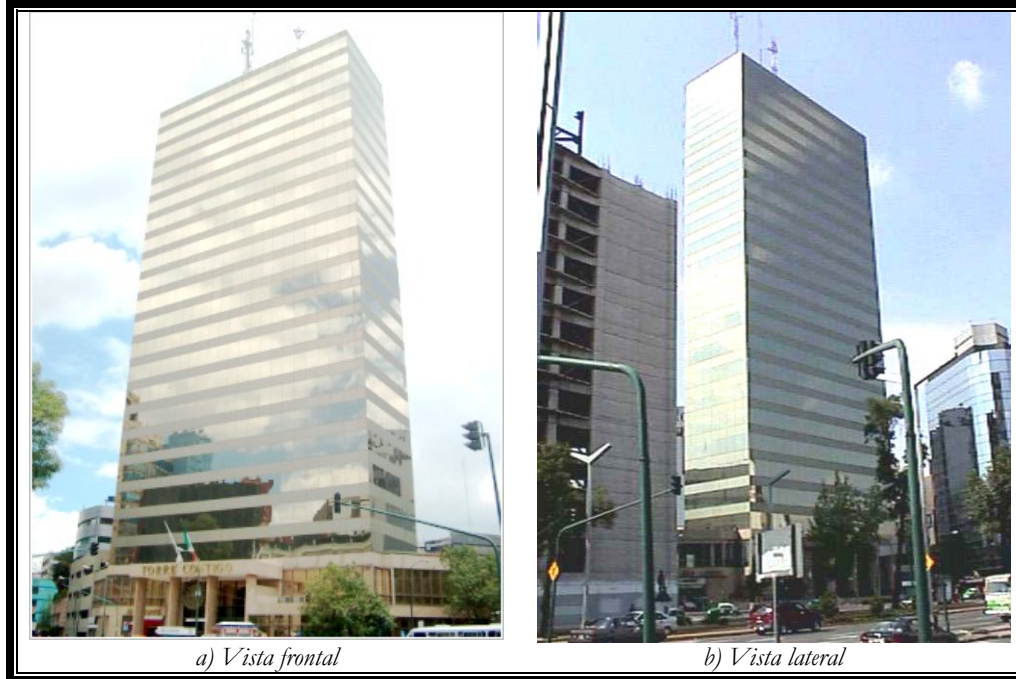
Figura 3.14. Vistas del edificio Reforma N° 51
