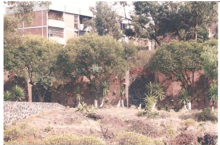
Foto: Gavetas junto a la barda perimetral del cementerio que se encuentran muy descuidadas.
