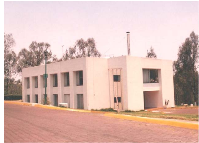
Foto: Edificio administrativo, salas de velación y crematorio del ISSSTE.
