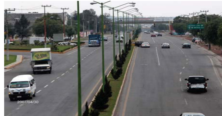
Imagen: Carretera federal México – Pachuca
