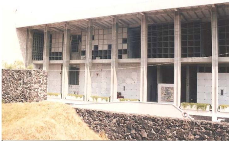
Foto: Fachada de un mausoleo, se ahorra material al incorporar las gavetas a la fachada, pero el edificio parece estar en obra negra mientras se ocupan todas las gavetas.
