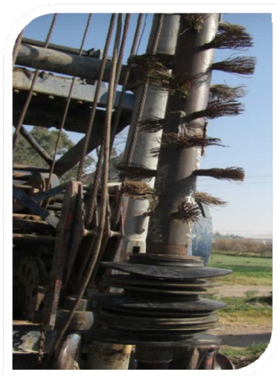
Figura 36.- Cepillo y Pistón utilizados en la Rehabilitación
