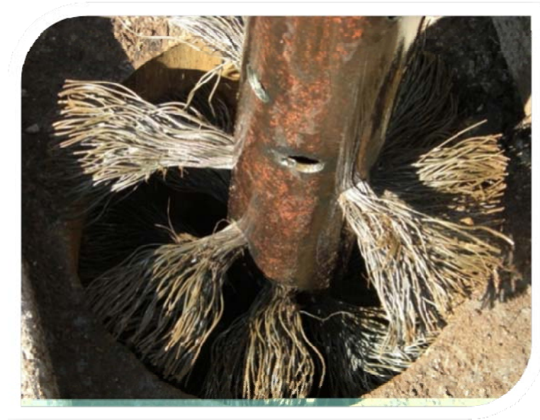
Figura 33.- Cepillado limpiando el Ademe
