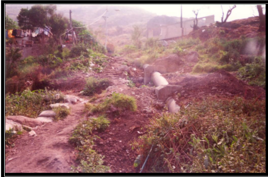
Fotografía No. 7 Vista de la calle Xicotencatl hacia el tanque GM-8
