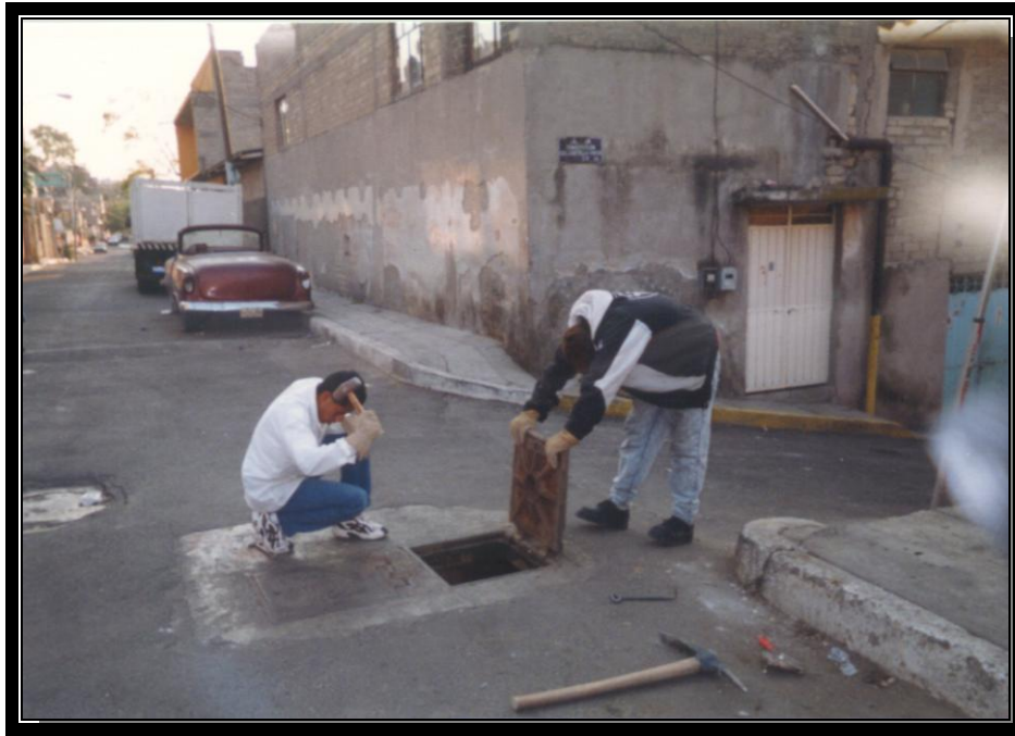
Fotografía No 17 Brigada de topografía realizando sondeo en las cajas de agua potable
