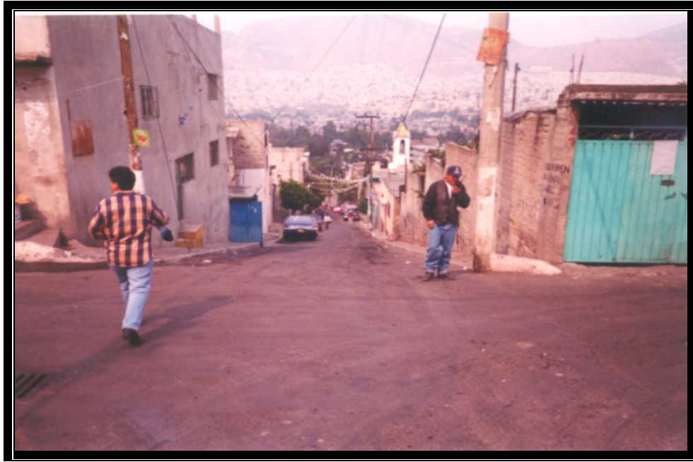
Fotografía No. 3 Trazo de la línea de proyecto sobre la calle Benito Juárez, vista desde la calle Tenochtitlan
