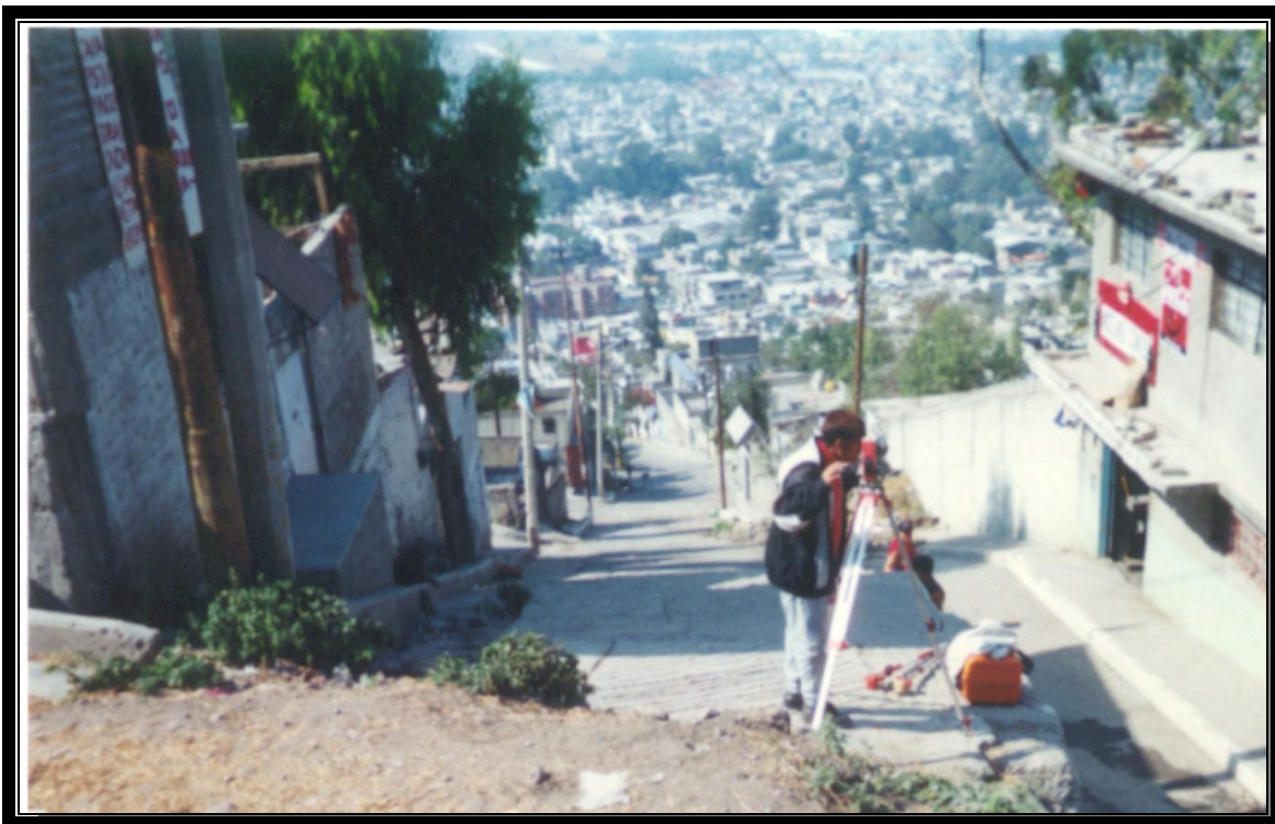
Fotografía No. 20 Ubicación de la estación total sobre el vértice "L" de la poligonal de apoyo
