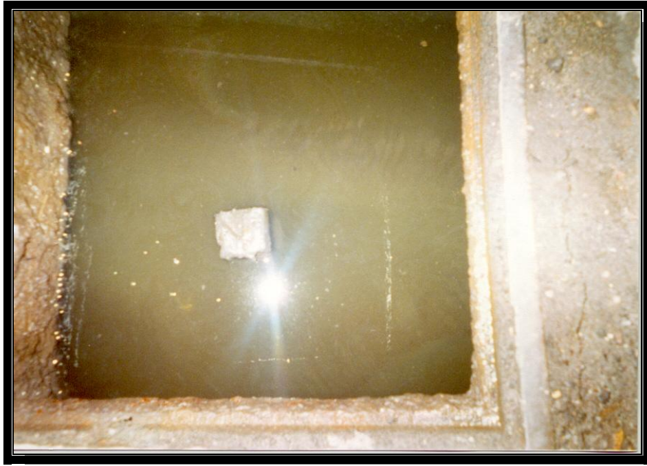
Fotografía No 15 Caja de agua potable (inundada) sobre la calle Benito Juárez y cerrada del Carmen
