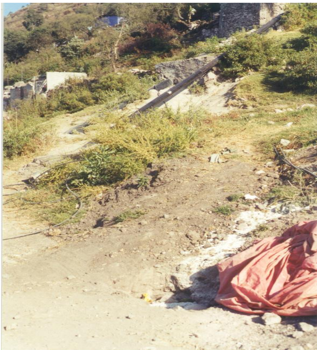
Fotografía No. 14 En la presente se muestran las tomas clandestinas que hay a lo largo de la línea de conducción
