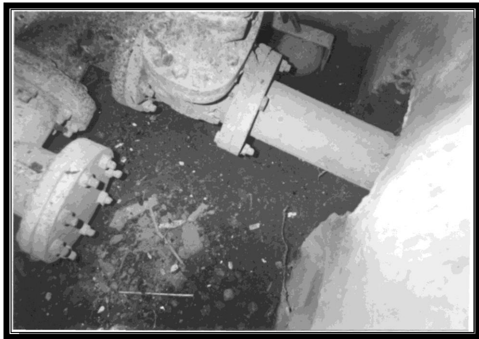
Fotografía No. 12. Conexión de una tubería existente en privada de Xicotencatl
