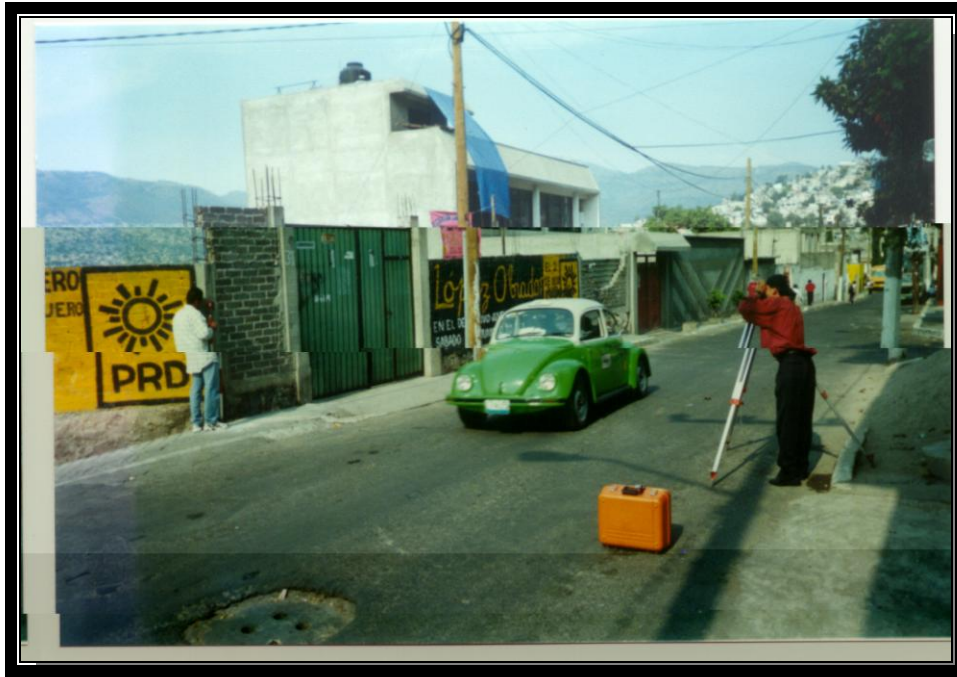
Fotografía No 19 Brigada de topografía realizando la ubicación de paramentos en la calle Tenochtitlan
