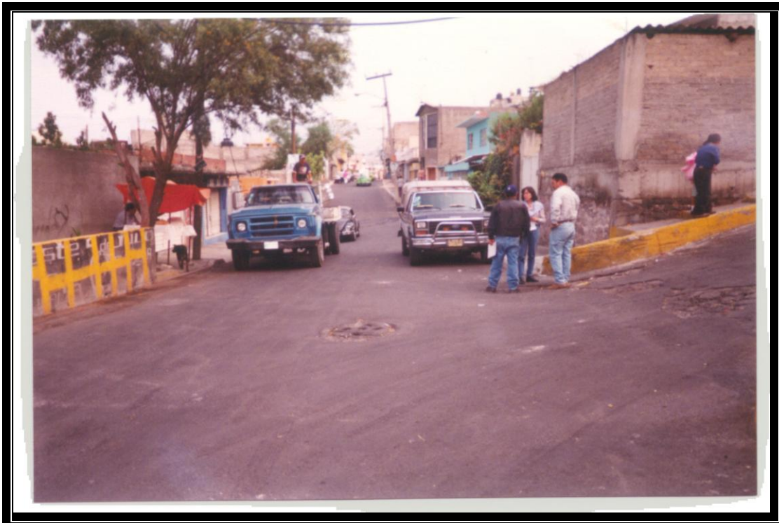
Fotografía No. 5 Trazo de la línea del proyecto sobre la calle Tenochtitlan vista desde la Xicotencatl
