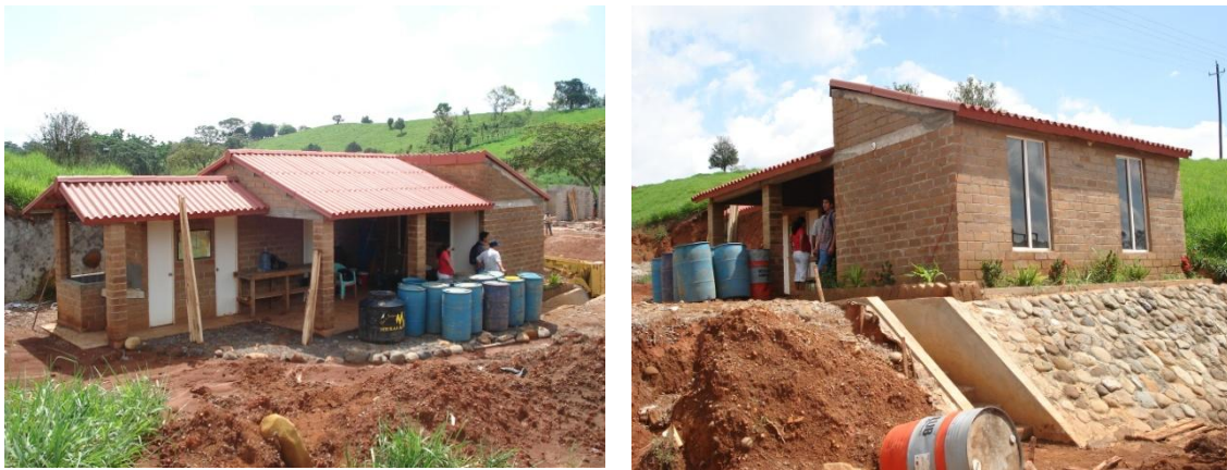
Imagen 7 y 8 Diseño y material de vivienda en Nuevo Juan de Grijalva.
