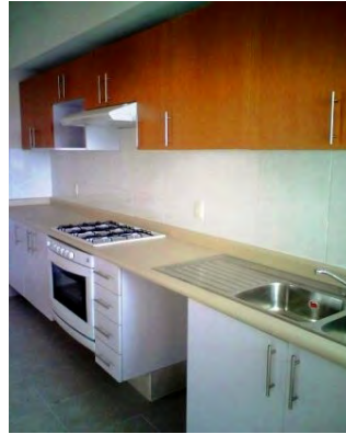
Figura 3 . 4 Estado del inmueble (cocina)
