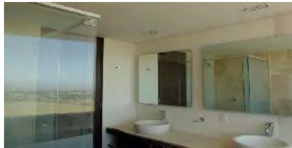
Figura 3 . 5 Estado del inmueble (baño)
