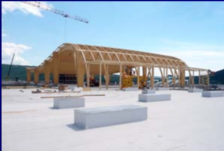
Colocación de techumbre a base de placas Kalzip
