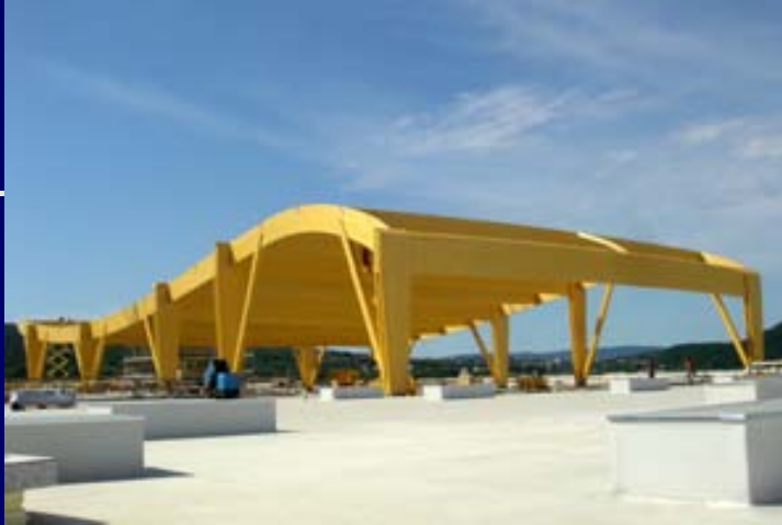
Parte posterior del edificios administrativo
