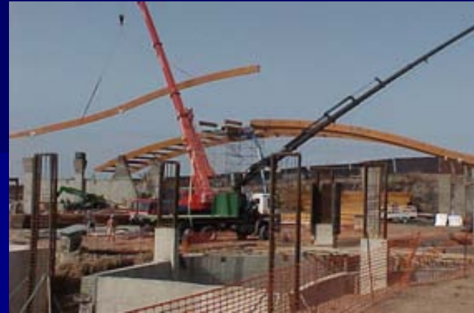
Sistema de ensamblaje de vigas
