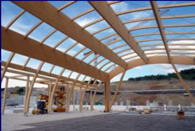
Parte interior de la estructura para las placas de Kalzip
