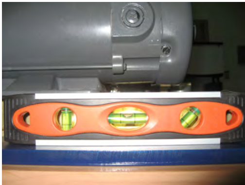
Figura 4.6: Alineación de la base metálica
