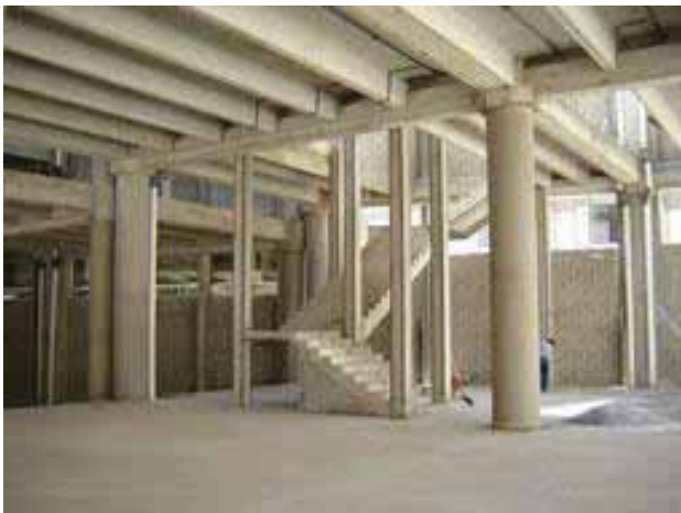
ESTRUCTURA DE ACERO
