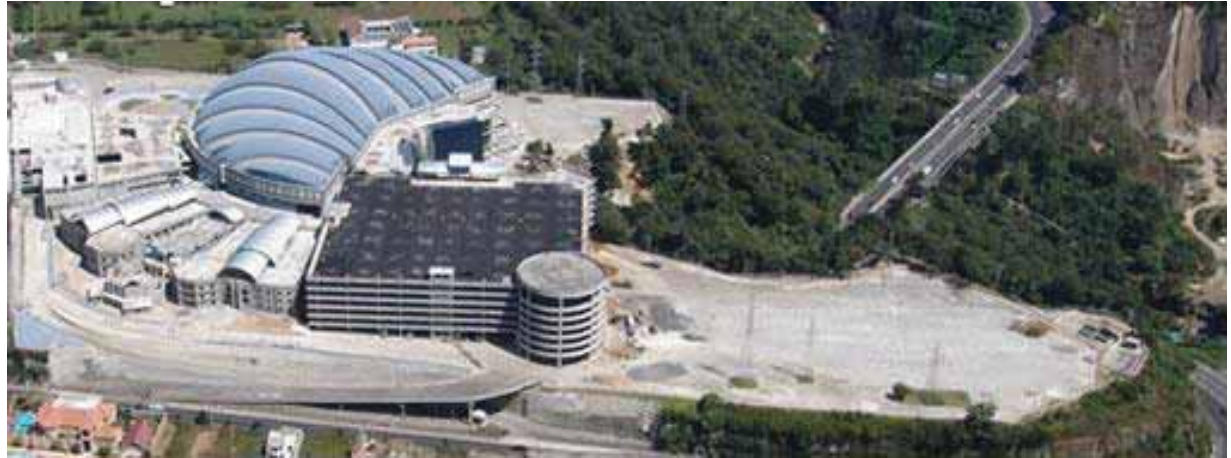
MEGA FRÁTER, ETÁPA DE CONSTRUCCIÓN Y ACABADOS. 2005
