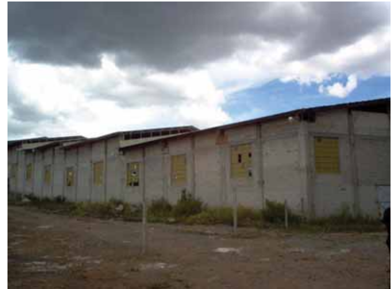
FACHADA LATERAL DEL TABERNÁCULO "LA MANSIÓN"
