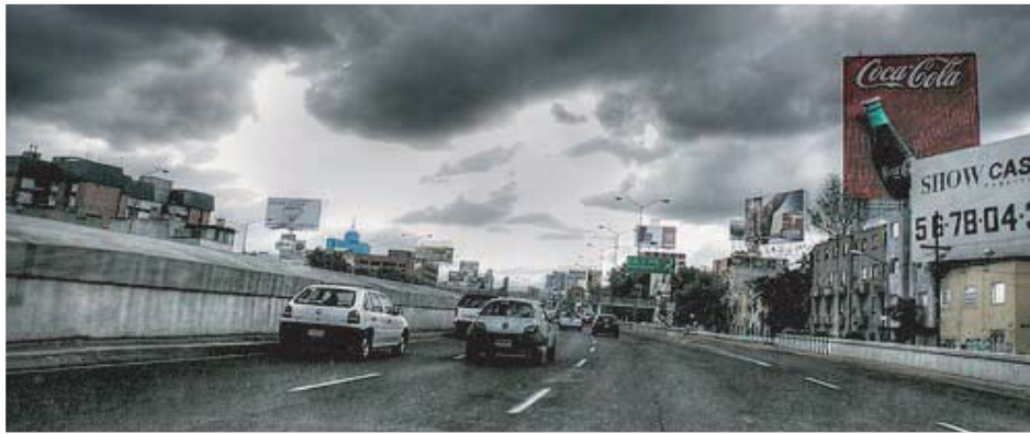
Viaducto Pte. Miguel Alemán
