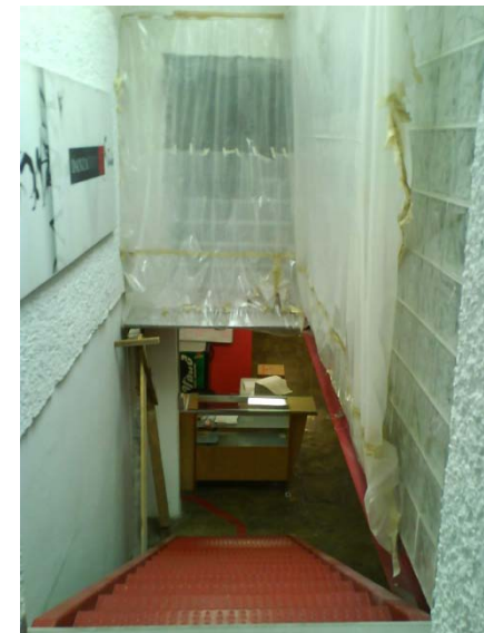
Derecha. Escaleras de acceso a la escuela
