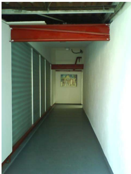
Izquierda. Pasillo de acceso desde la calle.
