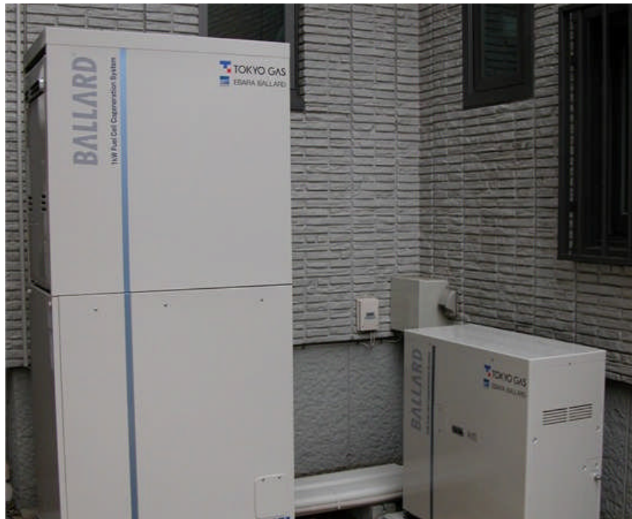
Fig. 3.2 Unidad de Tokio Gas fabricado por Ballard e incluye una pila de celdas de combustible (Mark1030). Este generador ha logrado una eficiencia total del sistema de cogeneración (calor y electricidad), del 92%, una de estas unidades se instaló en la residencia del primer ministro Japonés en abril de 2005. [36]
