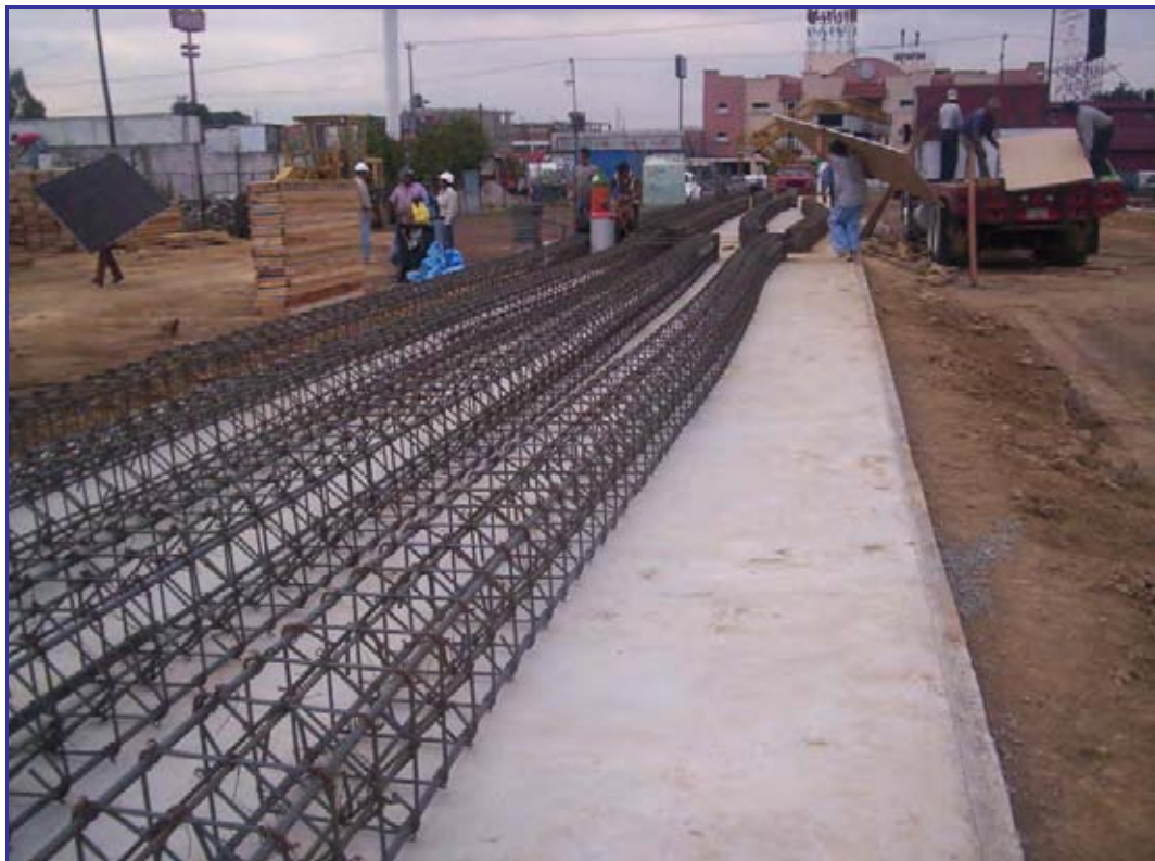
Refuerzo en pilotes
