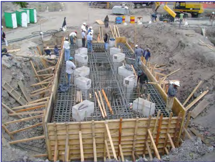
Cimbra de las zapatas.
