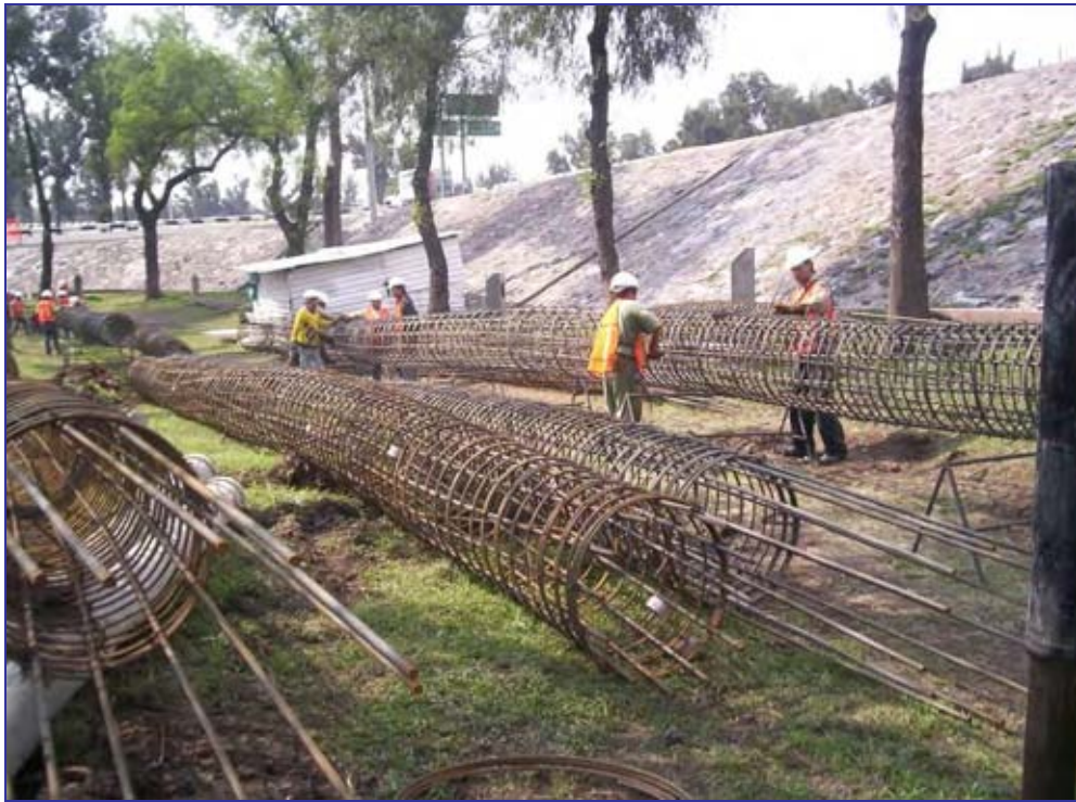
Armado de pilas en la obra.
