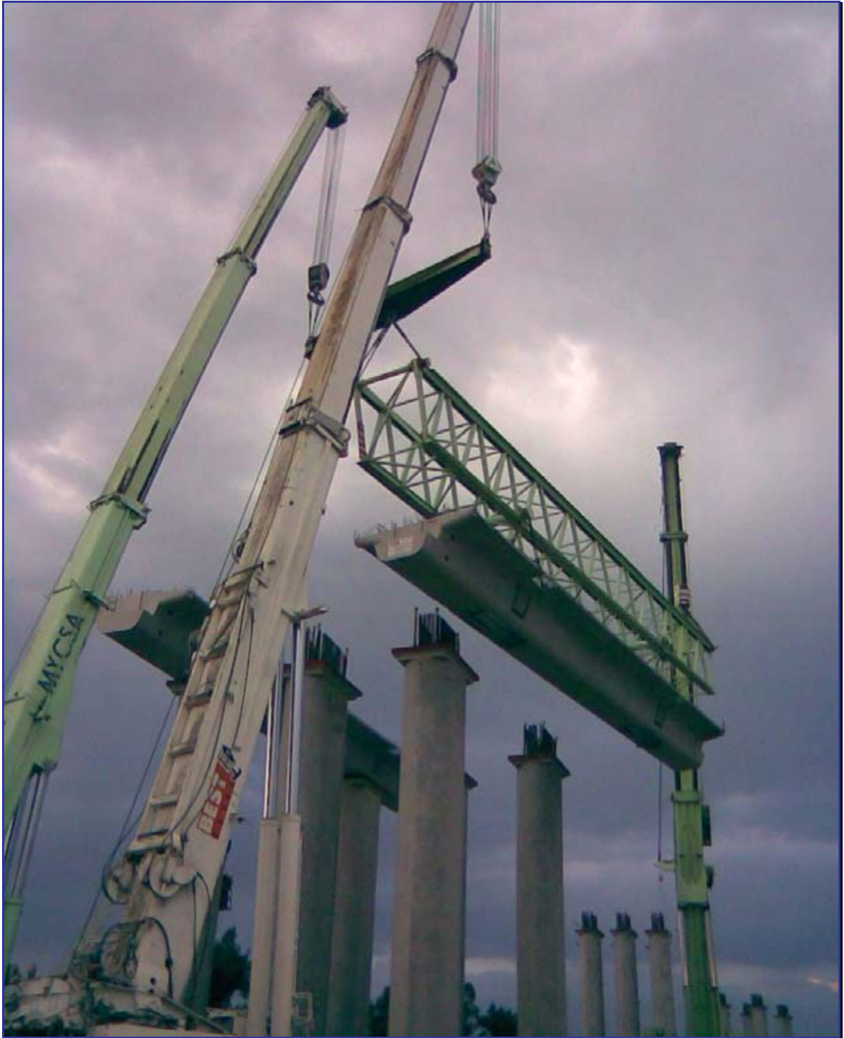
Montaje de traves TA.
