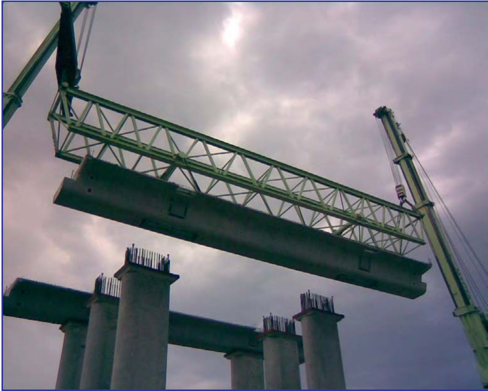
Montaje de traveses TA.
