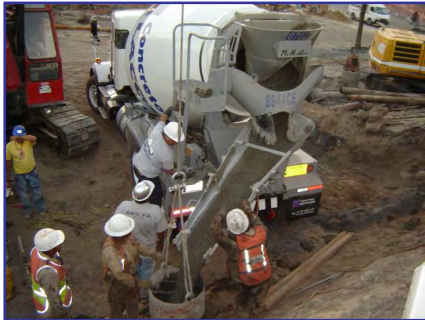
Colado de pila.
