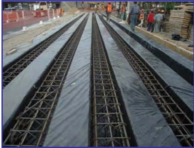
Fabricación de pilotes
