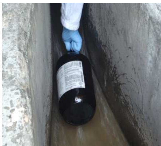
Figura 2.14 Canal de descarga del efluente de la planta de tratamiento de aguas residuales en C.U.
