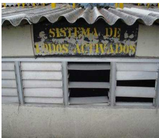
Figura 2.15 Sistema de lodos activados de la planta de tratamiento de aguas residuales en C.U.
