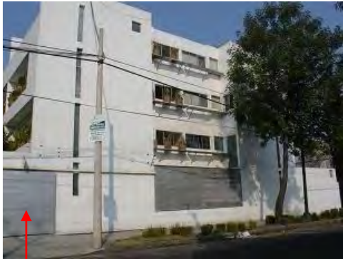
Acceso vehicular en fachada lateral edificio 252
