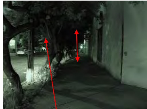
Otra vista de la fachada lateral. Árboles sin mantenimiento adecuado obstruyen iluminación creando un túnel oscuro y dificultando el paso peatonal.
