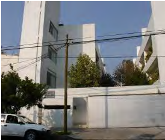
Fachada lateral sobre Calle Moras
