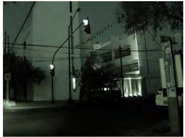
Fachada principal sobre Calle Miguel Laurent
