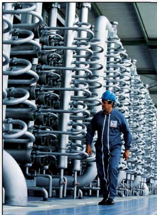
Figura 4.8. Trabajos de inspección en la planta. Tomado de http://www.veoliawater.com
