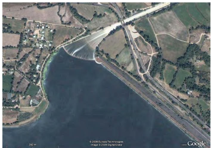
Figura 4.1. Vista aérea del vertedor de la presa Endhó. Tomado de Google Earth 2009.
