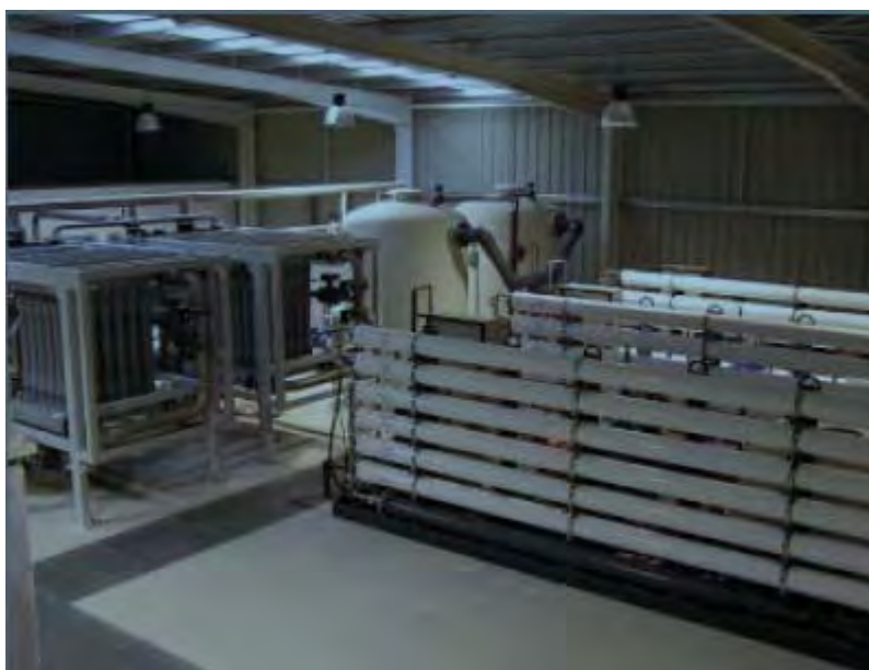
Figura 2.3. Ejemplo de un Sistema Integrado de Membranas. Tomado de (Sanz, Guerrero, & Ortega, 2005)
