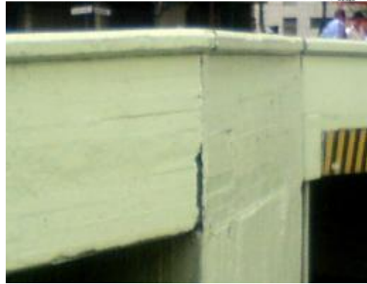
Figura 2.38 Av. Minería y Viaducto Miguel Alemán
