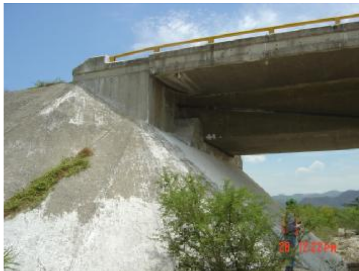
Figura 1.9 Estribo abierto semioculto en derrame del terraplén
