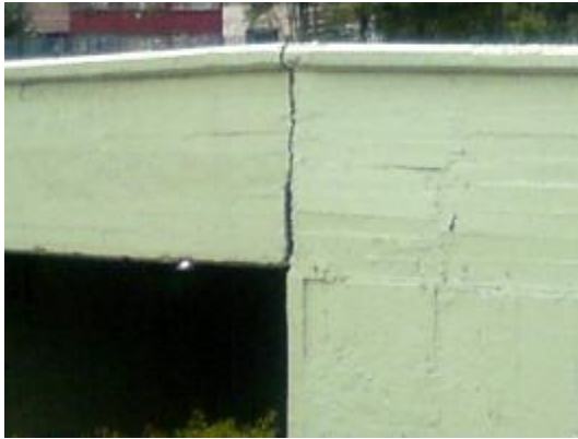
Figura 2.37 Av. Minería y Viaducto Miguel Alemán
