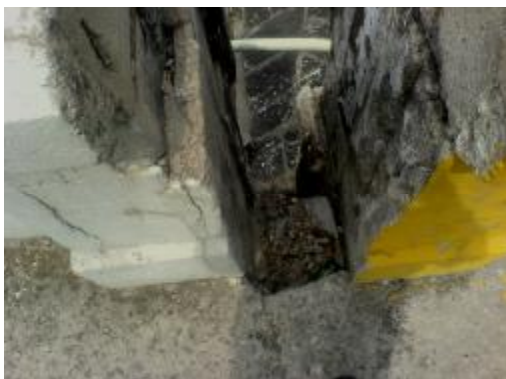
Figura 2.23 Av. Monterrey y Viaducto Miguel Alemán
