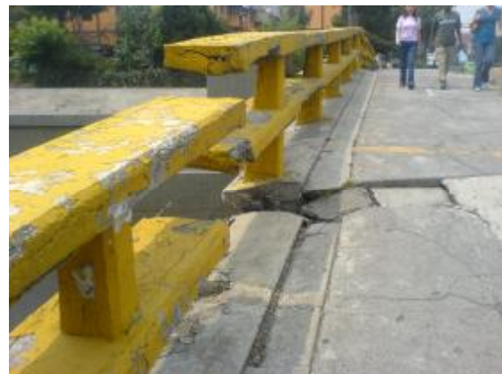
Figura 2.18 Av. 5 de febrero y Viaducto Río de la Piedad
