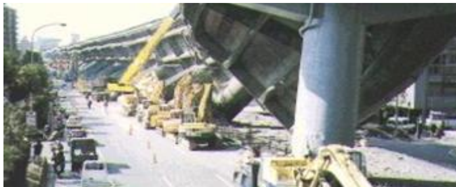
Figura 1.77 Daños en la vía rápida Hanshin (EQE, 1995)
