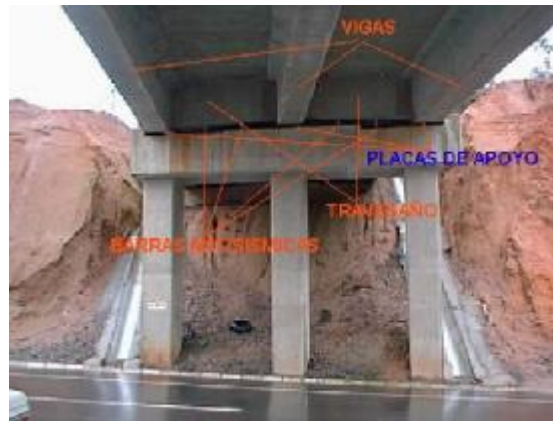
Figura 1.7 Estribo abierto con tres pilas o fustes
