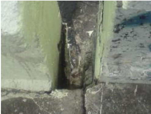
Figura 2.25 Av. Medellín y Viaducto Miguel Alemán
