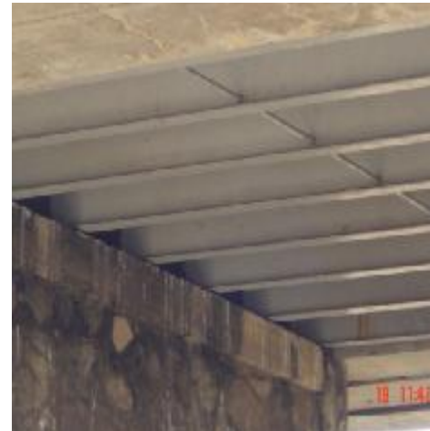
Figura 1.22 Estribo sin viga diafragma entre el muro de respaldo y las vigas
