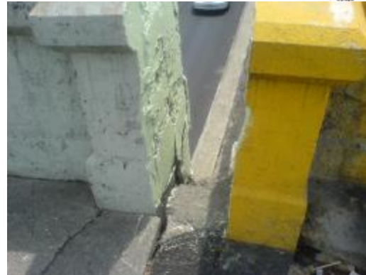
Figura 2.26 Av. Monterrey y Viaducto Miguel Alemán
