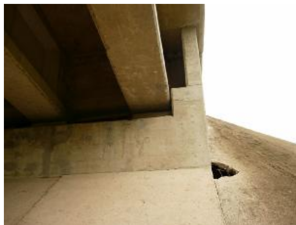
Figura 1.24 Solución con vigas laterales y diafragmas
