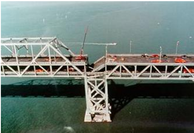
Figura 1.73 Derrumbe de un tramo de la superestructura del puente de la bahía Oakland San Francisco (Nakata et al., 1999)
