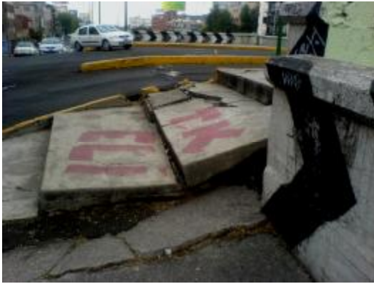
Figura 2.13 Av. Medellín y Viaducto Miguel Alemán
