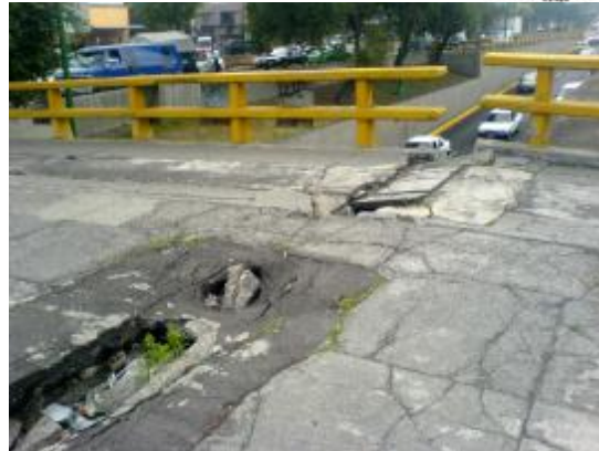
Figura 2.20 Calzada de la Viga y Viaducto Rio de la Piedad
