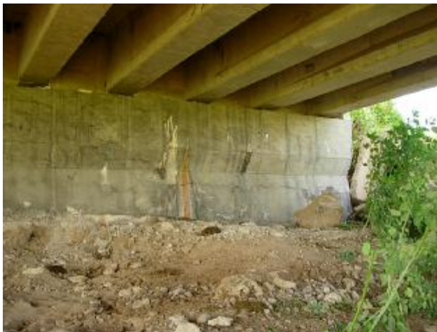
Figura 1.22 Estribo sin viga diafragma entre el muro de respaldo y las vigas
