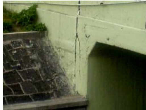
Figura 2.10 Av. Coyoacan y Viaducto Miguel Alemán
