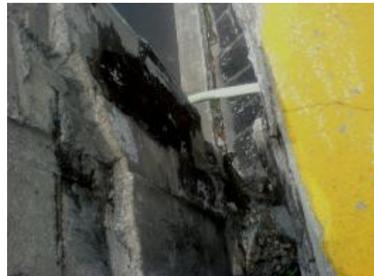
Figura 2.22 Av. Monterrey y Viaducto Miguel Alemán
