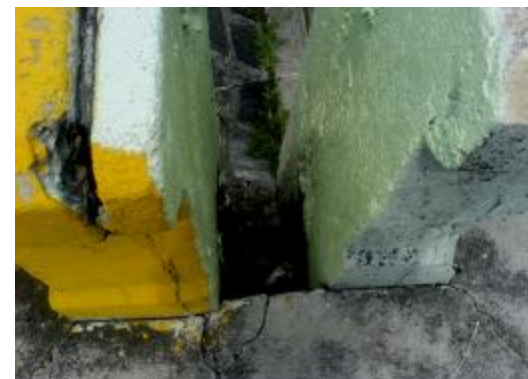
Figura 2.24 Av. Monterrey y Viaducto Miguel Alemán
