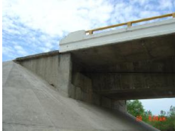
Figura 1.21 Corona del estribo adoptando la forma de la sección cajón del tablero
