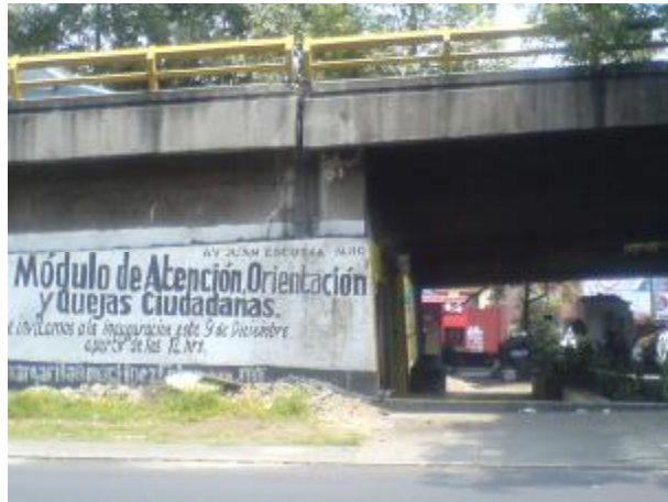
Figura 1.11 Estribos cerrado con muros en vuelta
