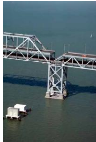
Figura 1.73 Derrumbe de un tramo de la superestructura del puente de la bahía Oakland San Francisco (Nakata et al., 1999)
