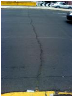
Figura 2.27 Monterrey y Viaducto Miguel Alemán
