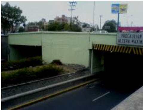
Figura 2.3 Av. Minería y Viaducto Miguel Alemán
