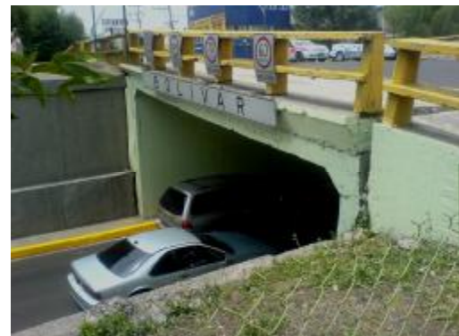
Figura 2.12 Av. Bolívar y Viaducto Miguel Alemán
