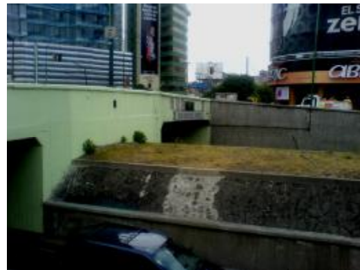
Figura 2.6 División del Norte y Viaducto Miguel Alemán
