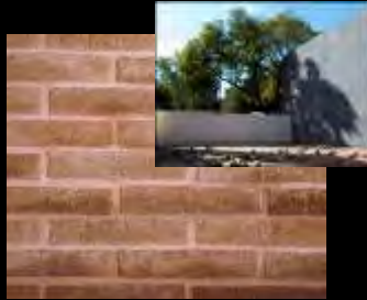
TABIQUE ROJO RECOCIDO EN MURO DE COLINDANCIA PATIO DEL MUSEO.
