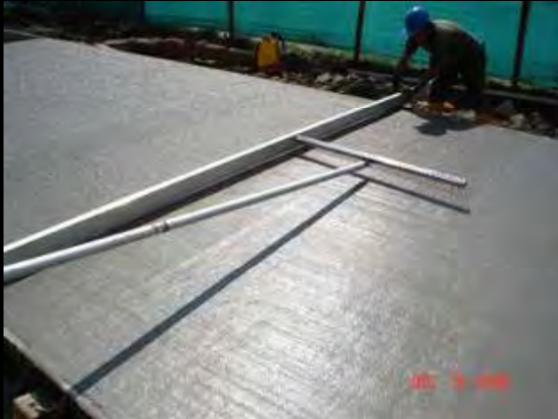
Losa de concreto armado.
