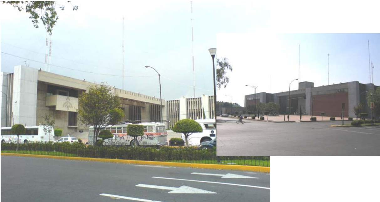
Edificio de oficinas de la Delegación Cuauhtémoc
