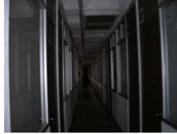
Foto 2: Pasillo principal planta baja
