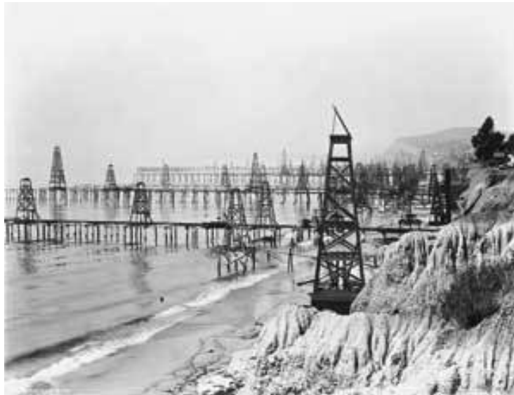
FIG I.2 Muelles habilitados para perforar Propiedad Offshore magazine
