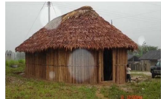
Tomada de: Iliana Herrera, Atuntiak, Vista exterior vivienda (Atuntiak), 2007, Foto (80)
