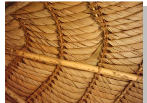
Tomada de: Iliana Herrera, Atuntiak, Vista de la Colocación de las hojas de turuji, 2007, Foto (108)
