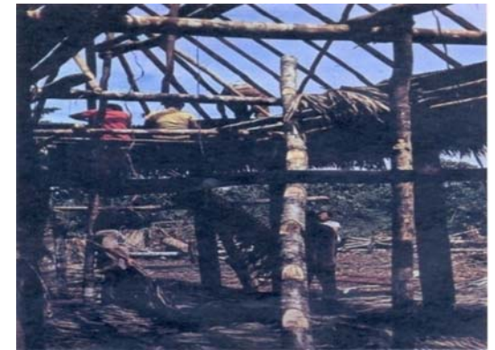
Tomada de: Iliana Herrera, Atuntiak, Montaje de la estructura de la casa Shuar, 2007, Foto (85)
