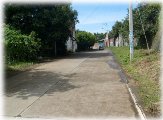
Ingreso hacia el terreno por la carretera hacia San Juan
