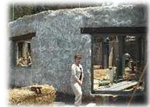
Muros de piedra volcánica
