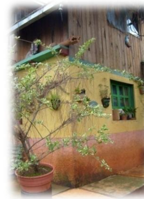
Casa de dos niveles con muros de tierra apisonada
