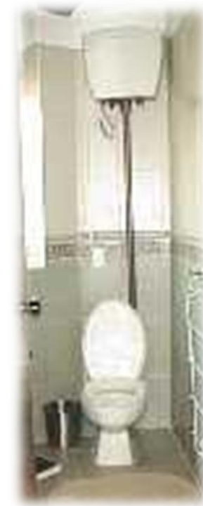
Colocación del tanque de agua
