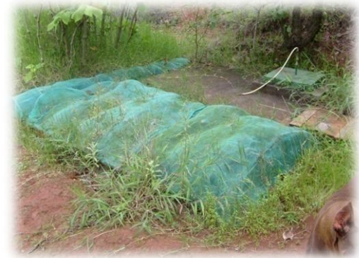
Planta tratadora de aguas negras y grises
