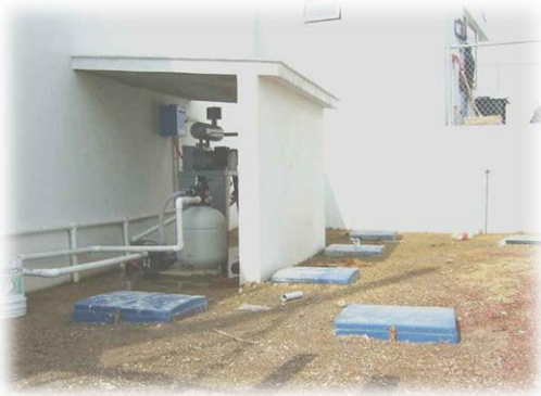
Fosa prefabricada ya instalada.
