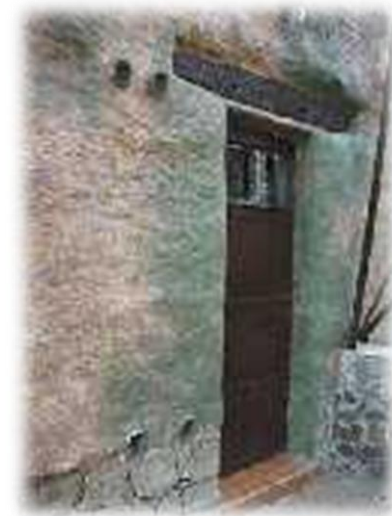
Vista de un muro de piedra
