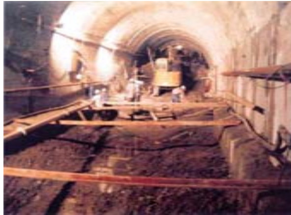
Figura 4.12. Excavación de la cubeta o solera
