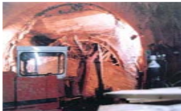
Figura 4.10. Etapa de excavación de la destroza.
