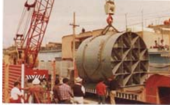
Figura 4.2. Escudo con rejillas frontales.
