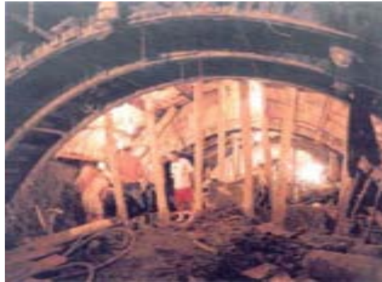
Figura 4.9. Etapa de excavación de la bóveda.
