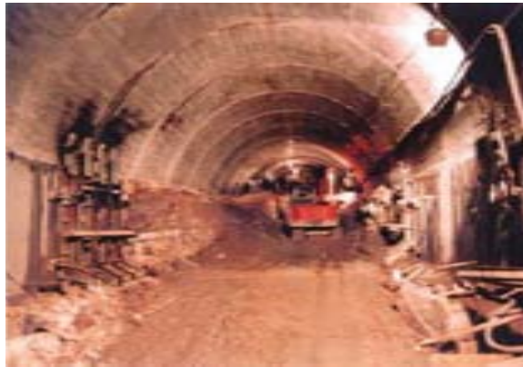
Figura 4.11. Excavación de los hastiales
