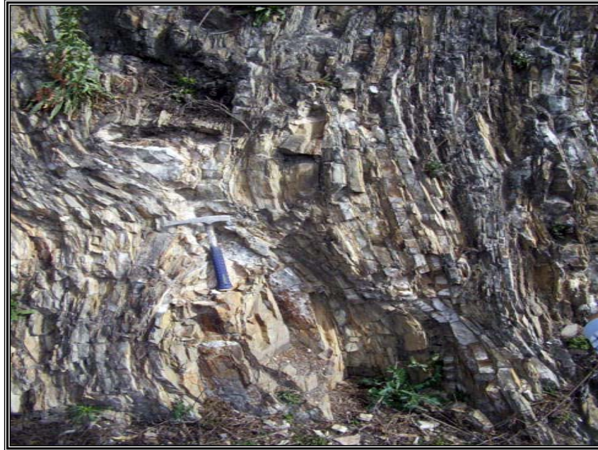
Fotografía 4.4 Afloramiento de la Fm. Las Trancas a lo largo de la Carretera Federal 85, nótese el desarrollo de "boudinage"
