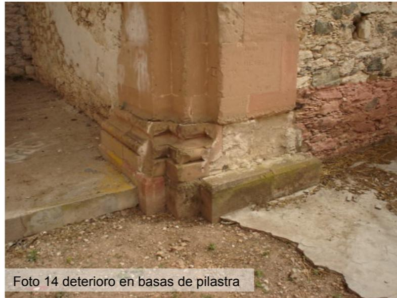
Foto 14 deterioro en basas de pilastra
