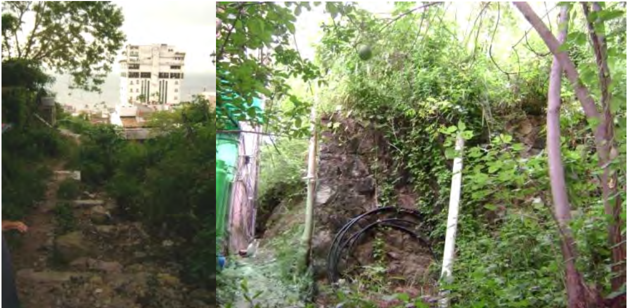
Figura 31. La imagen de la izquierda muestra la cañada por donde bajo el flujo de detritos en la calle Abasolo. La imagen de la derecha muestra una barda que fue parte de la casa que fue derrumbada por el flujo de 1993 sepultando y matando a dos de sus habitantes en la calle Abasolo en las partes altas del centro de la ciudad.
