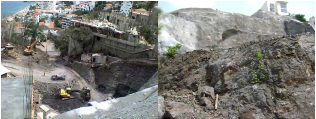
Figura 39. Cortes realizados a los cerros para la construcción de edificaciones.
