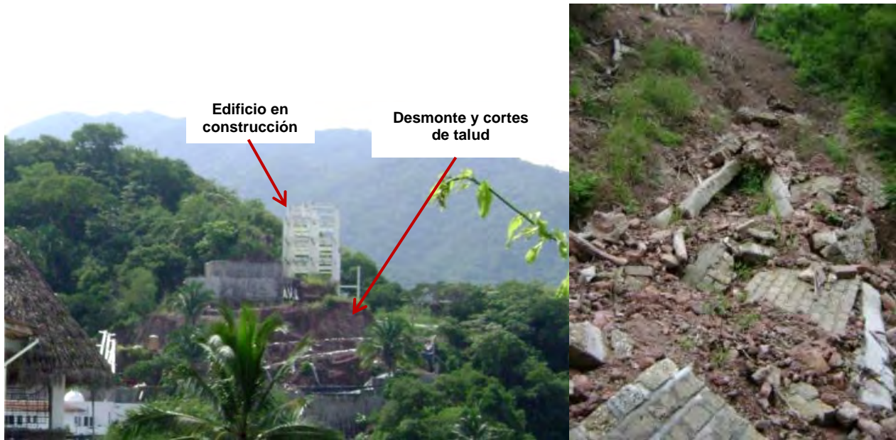
Figura 36. En la imagen de la izquierda se muestra las alteraciones a la ladera del cerro realizadas por una construcción. En la imagen de la derecha se muestra el material deslizado y los fragmentos de la barda que fue tirada por un flujo de detritos en julio de 2008.
