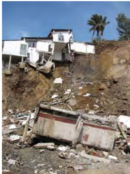
Figura 34. Imagen tomada del periódico El Faro (2007) donde se muestra el deslizamiento ocurrido en Villas de la Colina II.
