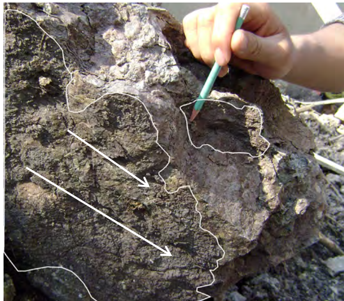
Figura 23. Rocas de un deslizamiento traslacional en Conchas Chinas las cuales presentaban arcilla (delimitado por la línea blanca) dentro de las diaclasas, este posible factor que contribuyó al debilitamiento de la masa de rocas. En la arcilla se presentan marcas de estrías que señalan la dirección del deslizamiento que se indica con las flechas.
