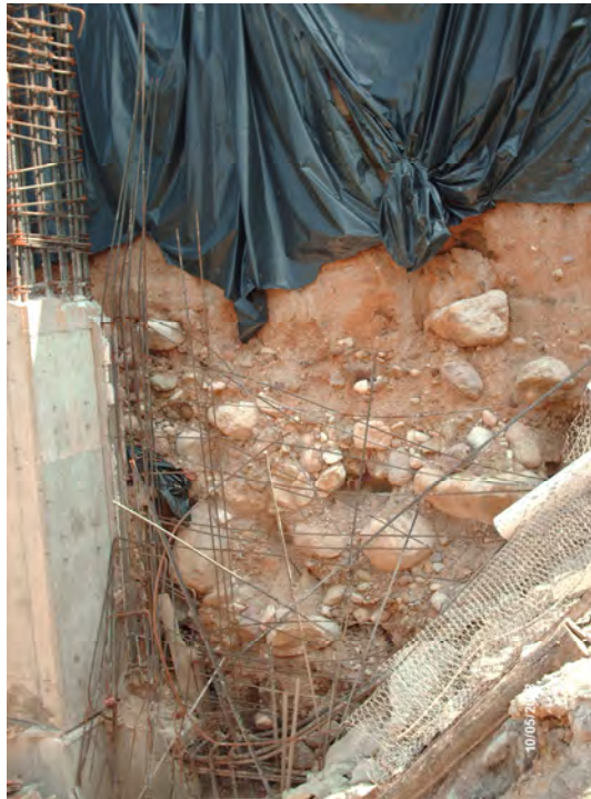
Figura 13. Secuencia terrígena inferior superior, donde se puede observar que los tipos de clastos que constituyen a esta secuencia, siendo estos los que mayormente la componen. La imagen pertenece a un corte hecho para una obra de construcción en la parte baja del fraccionamiento Amapas.
