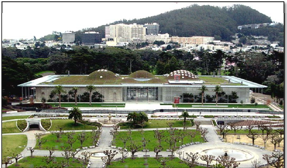
Imagen 20 Vista general de la cubierta de la Academia de Ciencias, California, EUA.
