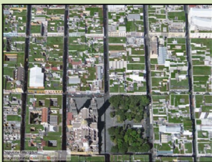
Imagen 14. Vista aérea que muestra cubiertas naturadas.
