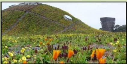
Imagen 18 Vista de la vegetación de la cubierta de la Academia de Ciencias, California, EUA.
