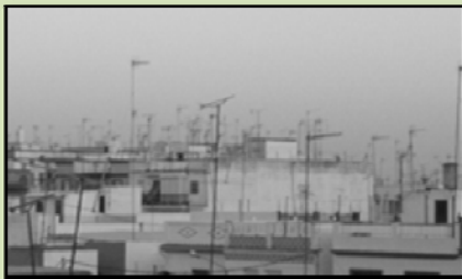
Imagen 7. Imagen de uso de las cubiertas como espacio para colocar antenas de televisión
