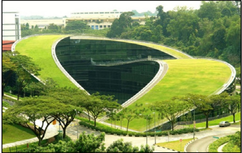
Imagen 17 Vista de la cubierta verde de la Escuela de Arte, Diseño y Medios de Comunicación de Nanyang, Singapur.
