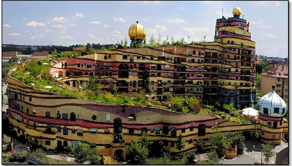
Imagen 23 Vista de conjunto del complejo residencial Waldspirale en Darmstadt, Alemania.
