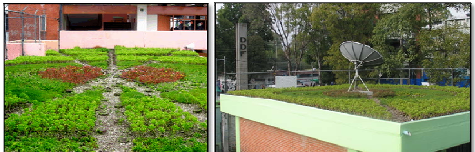
Imagen 30 Vistas de cubiertas verdes instaladas en Escuelas públicas en el Distrito Federal.
