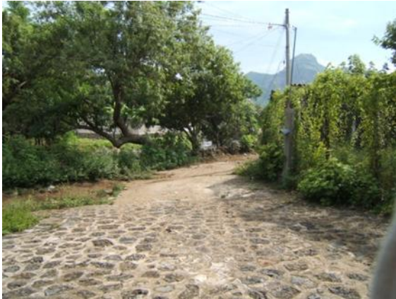
camino de piedra en acceso
