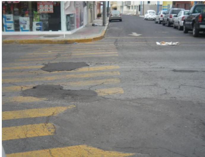
FIGURA 45.- Pavimento de asfalto dañado por el peso vehicular.
