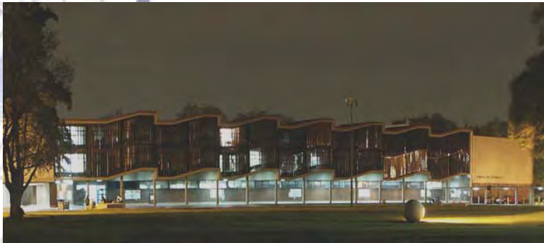
Centro de Investigaciones y Estudios de Posgrado de la Facultad de Arquitectura. (CIEPFA)
