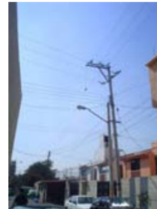
Levantamiento de luminarias
