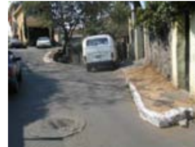
Levantamiento físico de banquetas existentes
