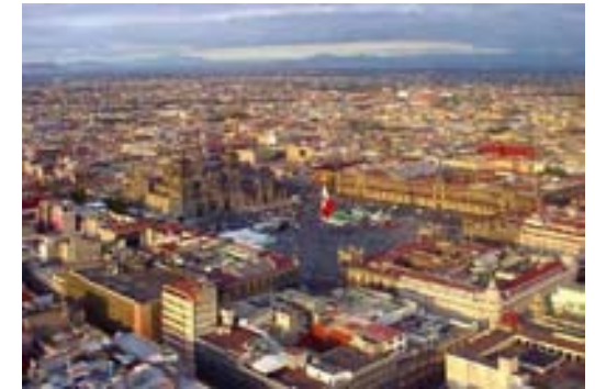
F-30 Dentro de los proyectos contemplados en el Programa Parcial de Desarrollo Urbano del Centro Histórico, está el de rehabilitar la Plaza de la Constitución, realizando el cierre a la circulación en Catedral y Palacio Nacional, cambiando pavimentos, colocando nueva iluminación, también se proponen la instalación de cafés al aire libre.
