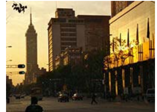
F-25 La zona tiene una de las infraestructuras más completas de la ciudad, sin embargo debido a su antigüedad y falta de mantenimiento esta se encuentra en mal estado.
