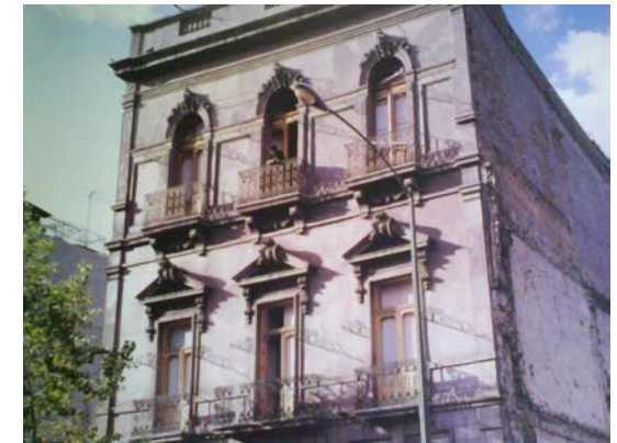
F-42 Se repusieron cristales, se consolidaron los marcos de madera de las puertas para dar este resultado. F-43 La fachada principal está en espera de ser remozada.
