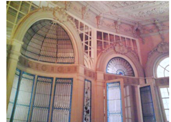
F-41 Algunas molduras de yeso, estaban incompletas y fue necesario reponer las faltantes.
