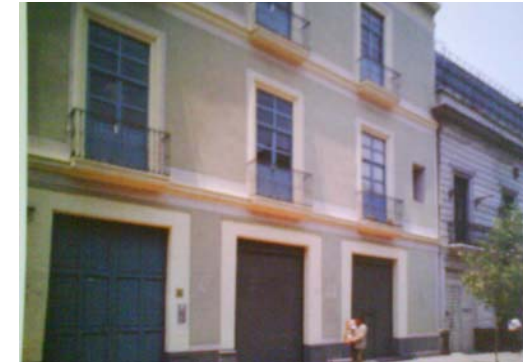
F-46 Se conservó la iluminación y ventilación de las áreas construidas hacia los mismos patios. F-47 Se respetó los elementos originales de la fachada.
