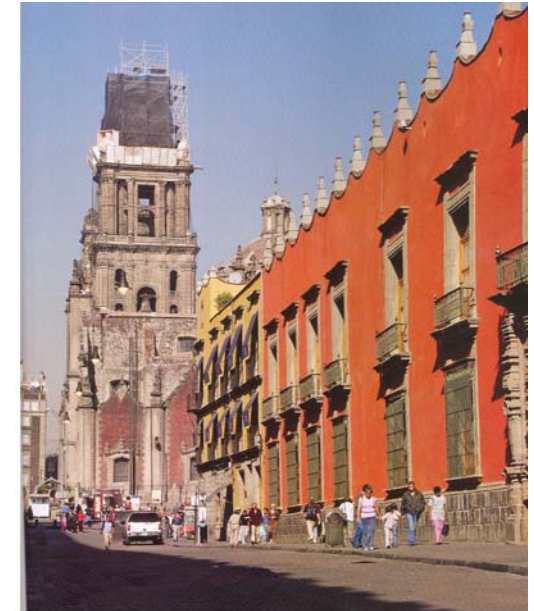
F-2 La Calle de Moneda frente al ex Palacio del Arzobispado. Se puede apreciar que la torre oriente de Catedral está en trabajos de restauración.
