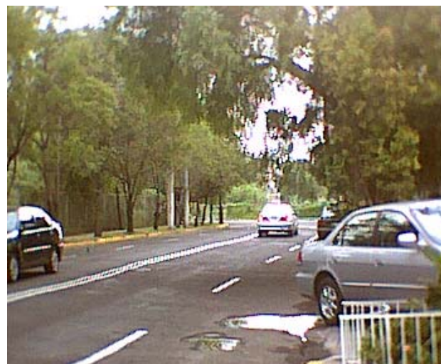
FOTO 8 (calle río bamba)
