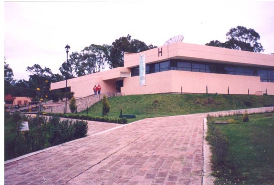
Edificio de Vinculación, destinado para tener enlace con el sector productivo de bienes y servicios, a través de visitas, prácticas, estancias y estadías.
