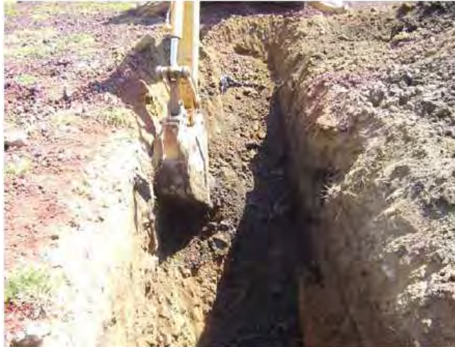
Figura 4.18.- Excavación de pozos a cielo abierto.
