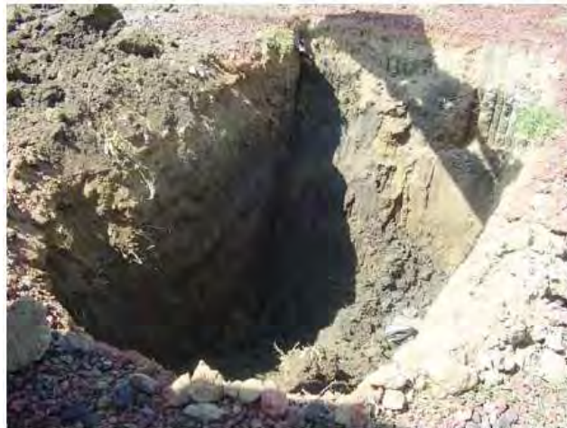
Figura 4.19.- Excavación de pozos a cielo abierto.
