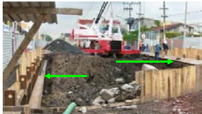
Se efectuó la colocación horizontal del perfil de viga madrina IPR de 10", este perfil se fija a las vigas IPR de 8" colocadas verticalmente
