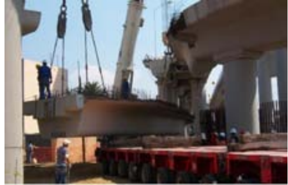
El modular acerca la pieza lo más cerca posible del lugar del montaje
