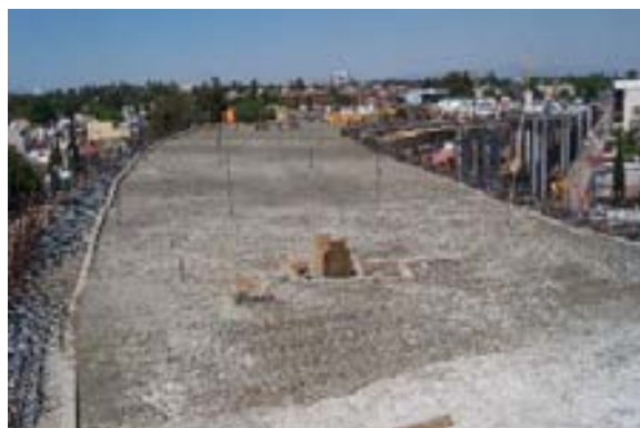
El concreto para el firme de compresión ocupa una resistencia de 300 \text{ kg/cm}^2
