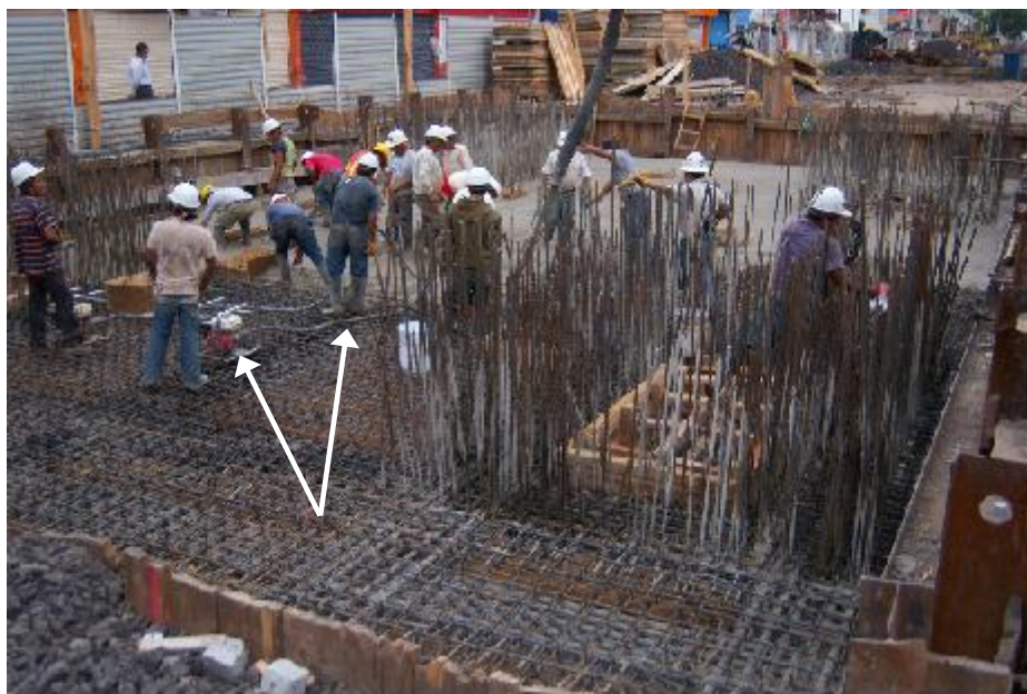
Utilización del vibrador en el colado de la losa tapa para lograr el acomodo de la mezcla
