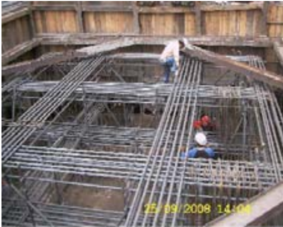
Armado del acero principal longitudinal y transversal con varilla del #12
