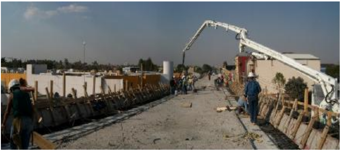
Cimbra metálica del parapeto de concreto
