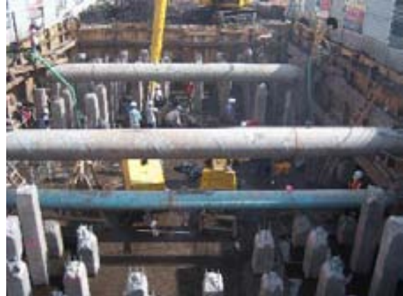
Colocación del segundo nivel de Troqueles ó Puntales
