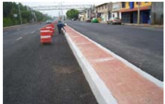
Aplicación de pintura a la guarnición
