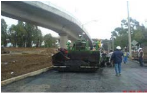
Tendido de carpeta asfáltica bajo puente
