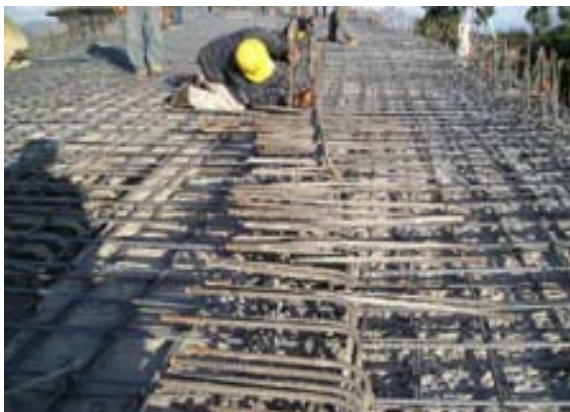
Se efectúa el anclaje entre el acero de la trabe y el acero del firme de compresión.
