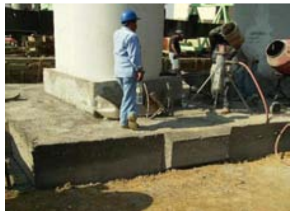
Inyección del Grout en las mangueras
