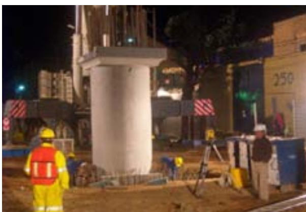
La brigada de topografía procede a verificar la alineación y nivelación de la columna
