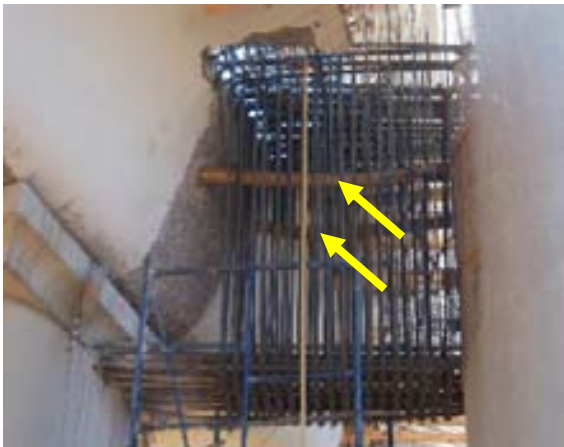
Ductos por donde pasan los Torones que efectuaran el tensado de trabe-trabe
