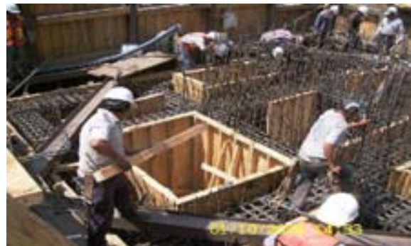
Apuntalamiento de la cimbra
