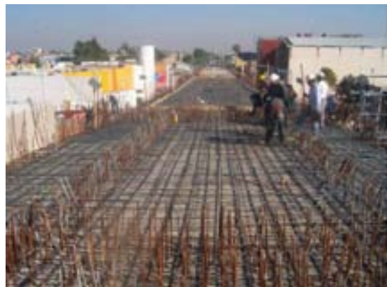
Para el armado del firme de compresión se utilizaron varillas del #4 y del #3
