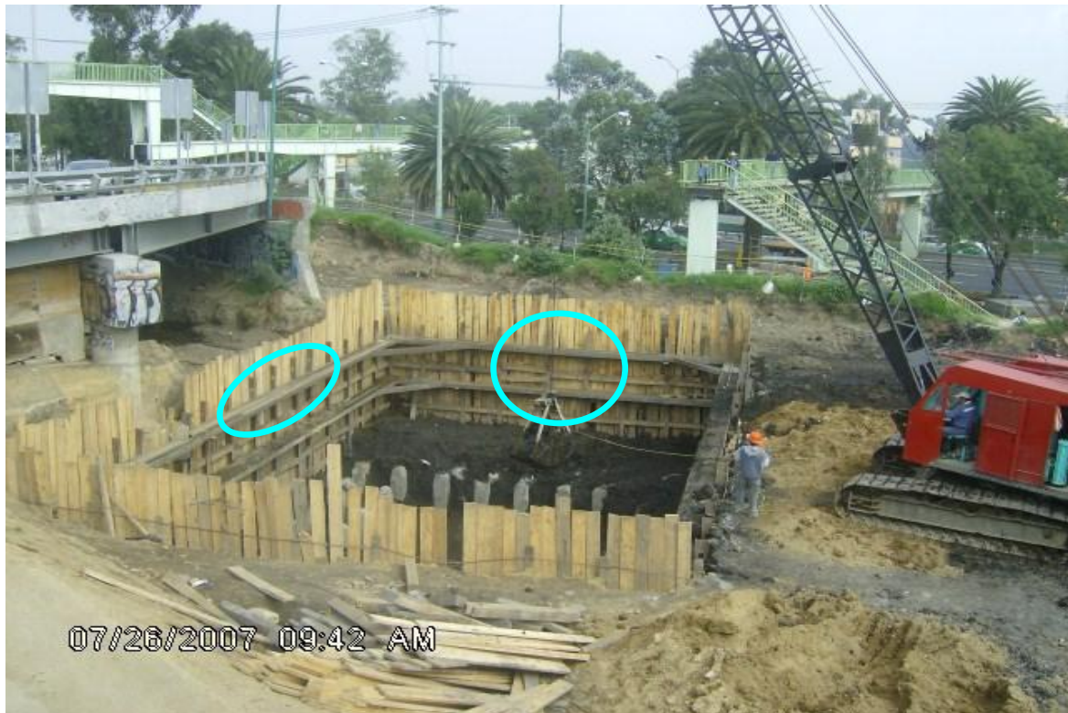
Cinturones de Vigas Madrinas IPR de 10''
