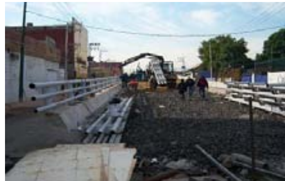
Colocación del parapeto metálico
