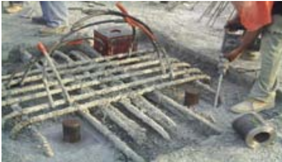
Descimbrado y preparaciones para iniciar el pos tensado de los torones.
