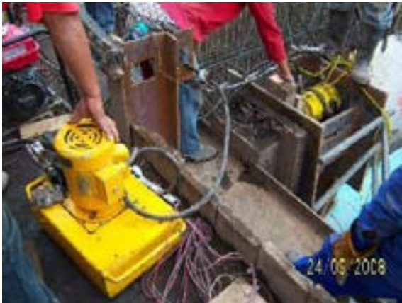
Colocación del segundo nivel de Troqueles ó Puntales
