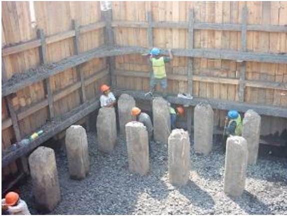
Colocación de la capa rompedora de capilaridad a base de una plantilla de Tezontle en greña acomodado hasta el 95% de su densidad.
