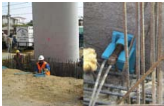
Descenso de la columna hasta el fondo del candelero y colocación de las cuñas estabilizadoras metálicas
