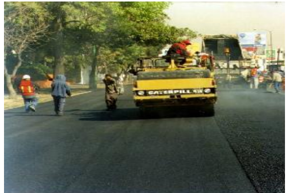
Terminado con plancha de rodillo de neumaticos
