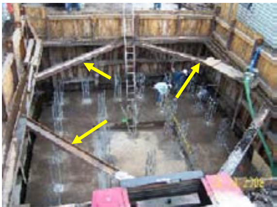
Colocación de las Patas de Gallo con IPR de 10''
