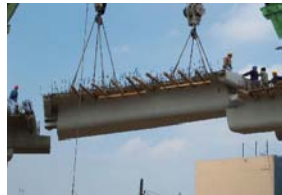
Trabe TC (Trabe de conexión)
