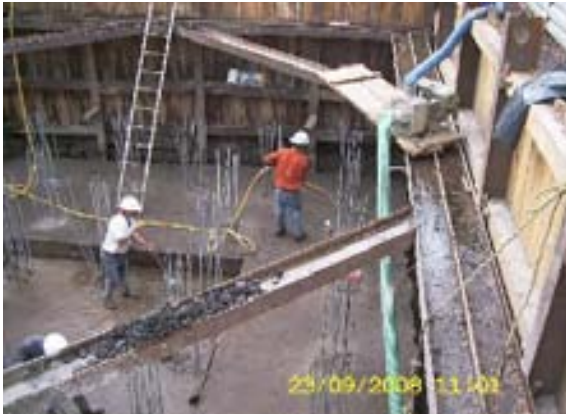
Limpieza de la zapata para empezar con el armado de la losa fondo
