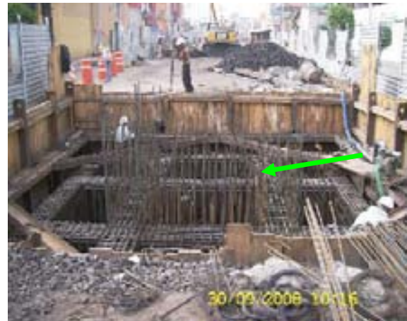
Armado de las paredes del Candelero revestido con estribos del #5
