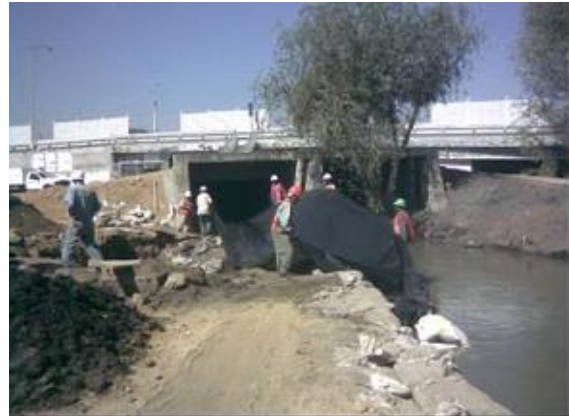
Confinamiento del área mediante costaleras
