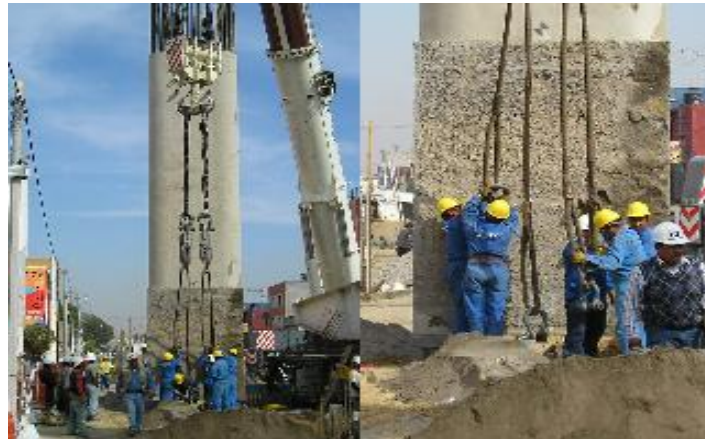
Se sueltan los grilletes que se encuentran conectados con los estrobos de la grúa de pateo
