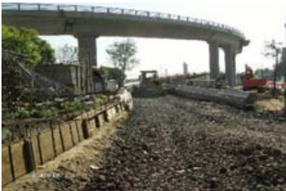
Colocación del relleno aligerado a base de tezontle en greña para formar el terraplén
