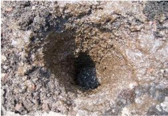
Perforación previa para el hincado de vigas
