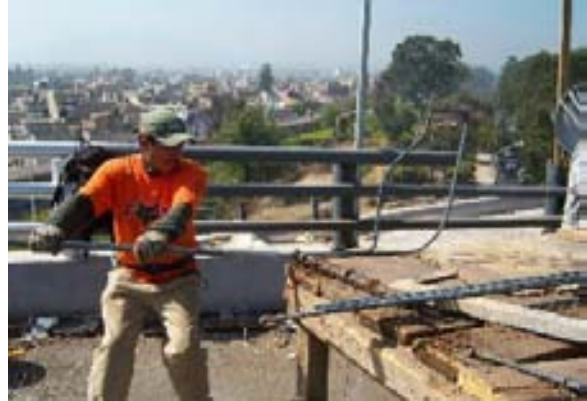
Habilitado del acero para candeleros y contratrabes
