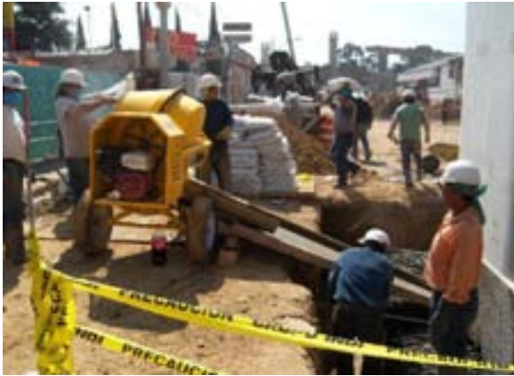
Colado del Grout para rellenar los espacios que existen entre el dado de la columna y las paredes del candelero.
