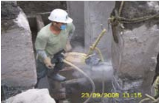
Descabece de pilotes por medio de martillos neumáticos rompedores
