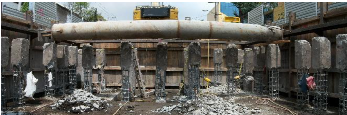
Demolición del pilote hasta descubrir acero en una longitud de 1.0 metro
