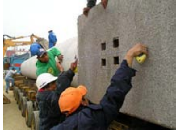
La brigada de Topografía verifica la geometría, alturas y niveles de la columna
