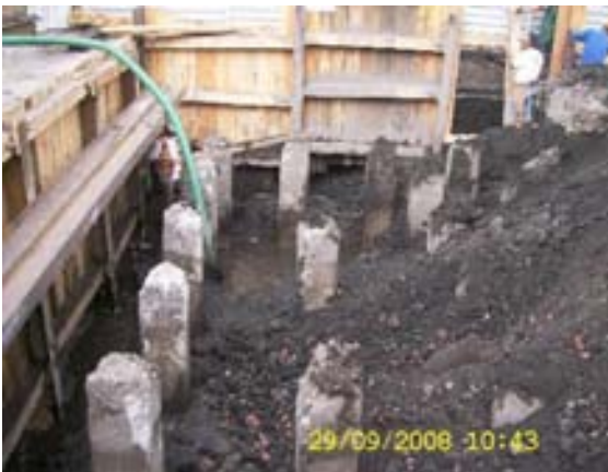
Bombeo de achique para resolver la inundación de las zapatas
