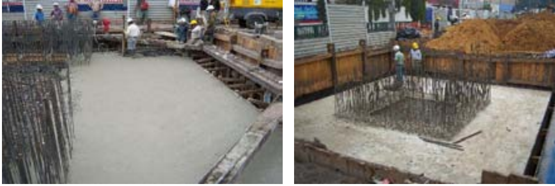
Colado de la losa tapa finalizado
