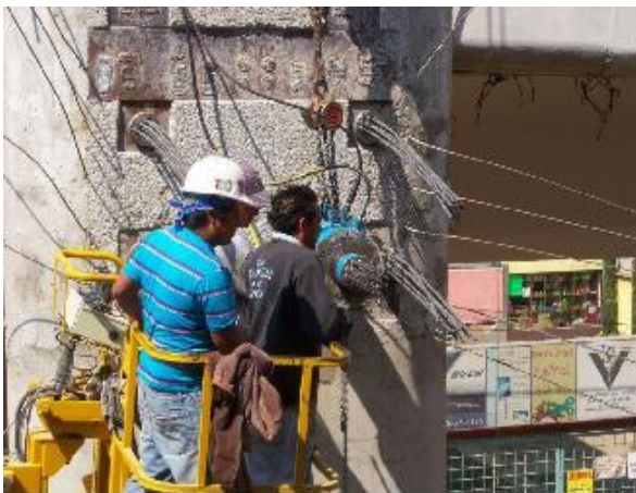
Procedimiento del Tensado del Cabezal
