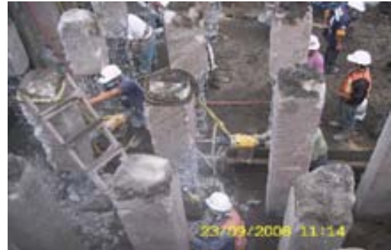
Descabece de pilotes por medio de martillos neumáticos rompedores
