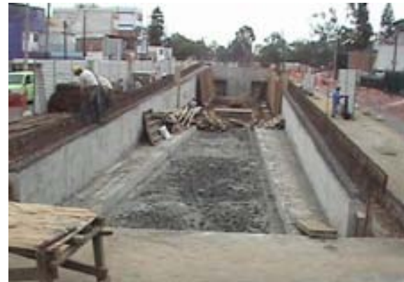
Muros de contención ya colados
