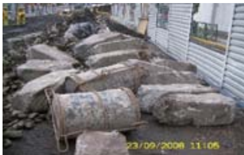
Fragmentos de concreto procedentes de la demolición de pilotes.
