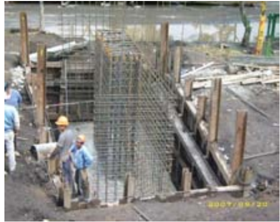
Colado de la zapata del muro estribo
