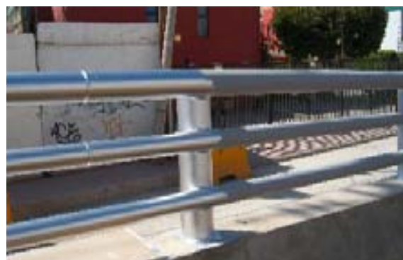
Sobre el primario anticorrosivo se aplica la pintura de esmalte color plateado
