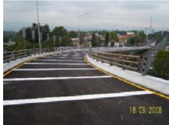
Señalamiento horizontal a nivel sobre puente
