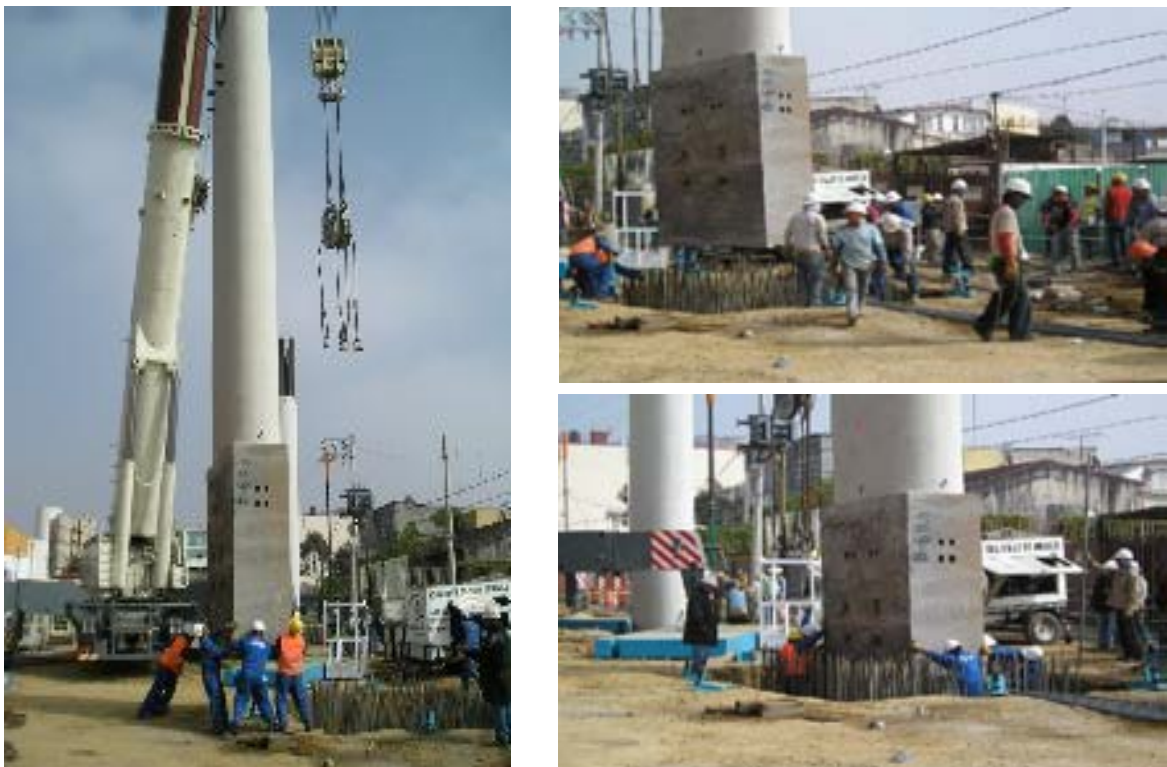
Se introduce la columna dentro de la zapata
