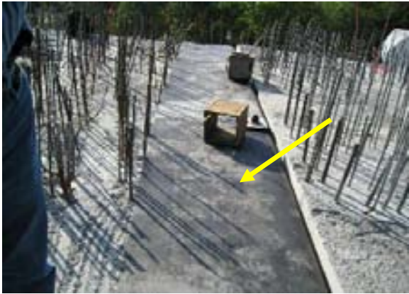
Colocación de una junta de calzada
