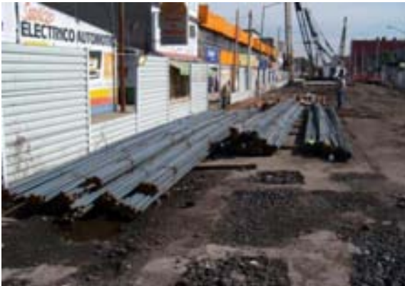
Habilitado del acero para candeleros y contratrabes
