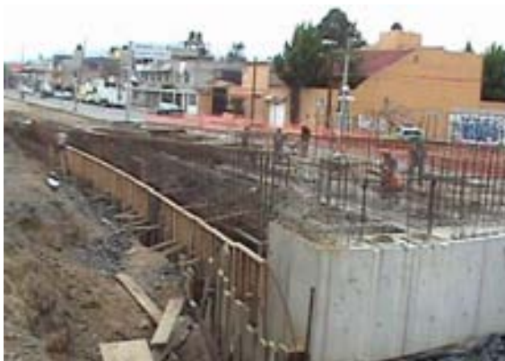
Cimbrado de los muros de contención
