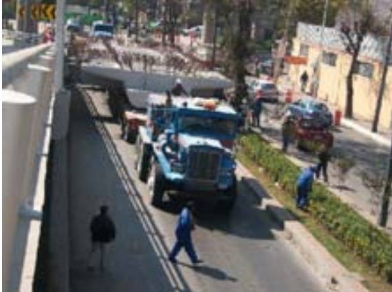
Traslado del elemento prefabricado mediante transporte tipo modular
