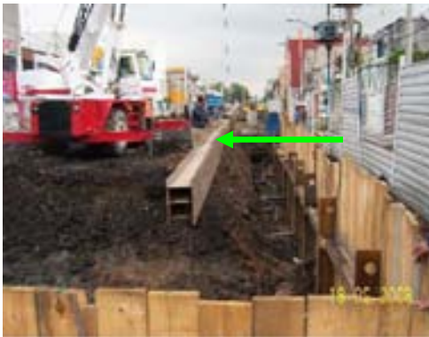
Se efectuó la colocación horizontal del perfil de viga madrina IPR de 10", este perfil se fija a las vigas IPR de 8" colocadas verticalmente
