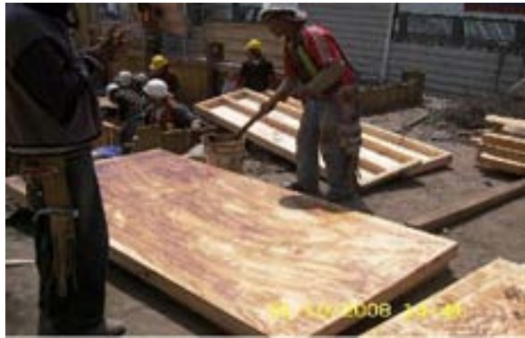
Aplicación de desmoldante
