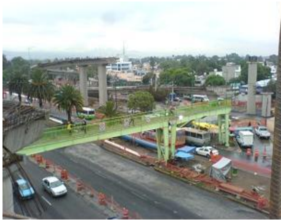
Retiro de puente peatonal que cruza el anillo periférico
