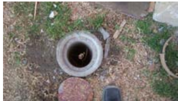
Sistema de tierras a base de un tubo de concreto de 20cm de diámetro que aloja a la varilla
