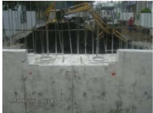
Colado del muro estribo
