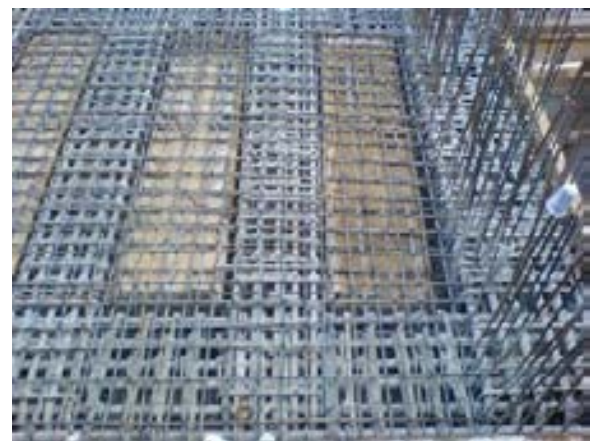
Armado de la losa tapa con varilla del No. 4 a cada 15cm, en dos parrillas
