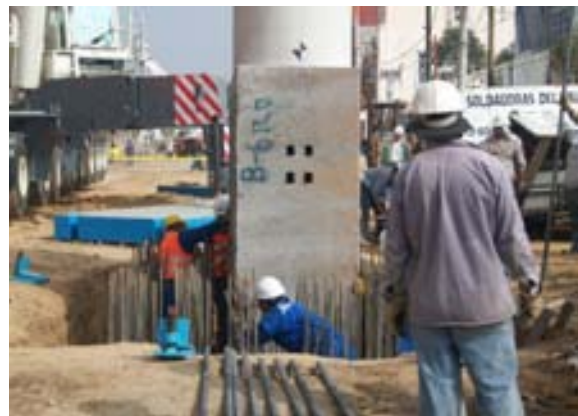
Recuperación de cuñas estabilizadoras
