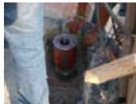
Descimbrado y preparaciones para iniciar el pos tensado de los torones.
