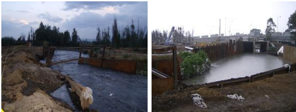
Canalización de aguas negras del río San Buena Aventura sin interferir con los trabajos de excavación
