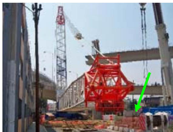
Confinamiento del área de montaje
