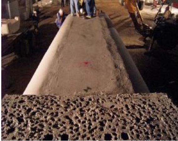
Escarificado de las caras del dado de conexión de la columna
