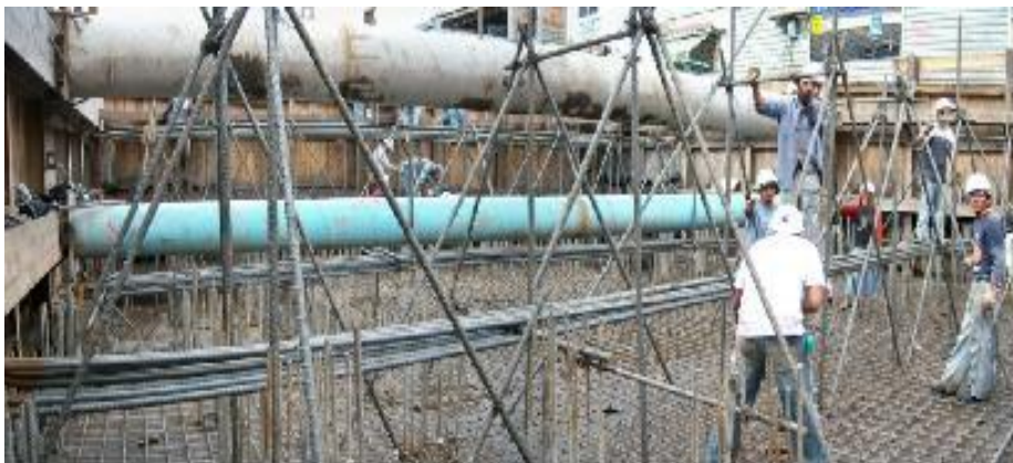
Armado de contratrabes
