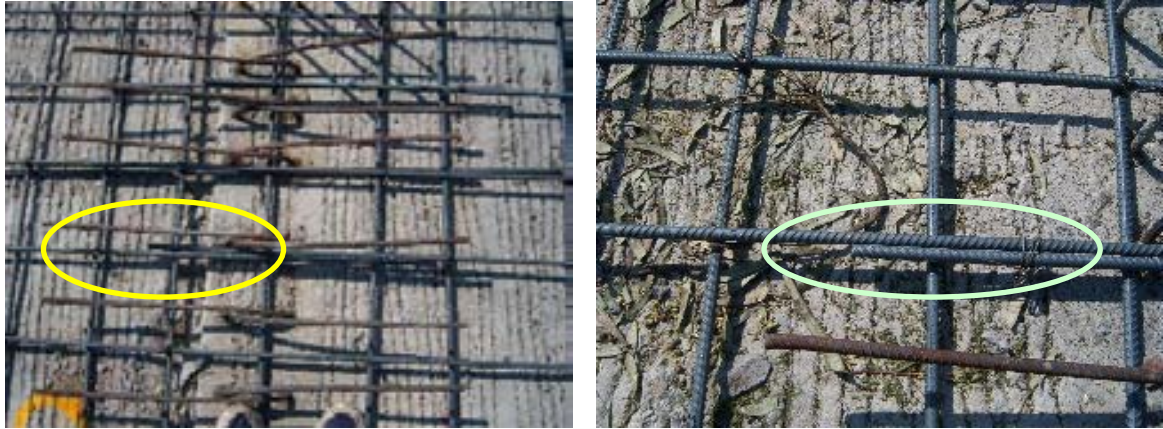
Empalme traslapado varilla menor del #8
