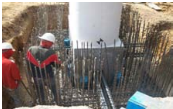
Descenso de la columna hasta el fondo del candelero y colocación de las cuñas estabilizadoras metálicas
