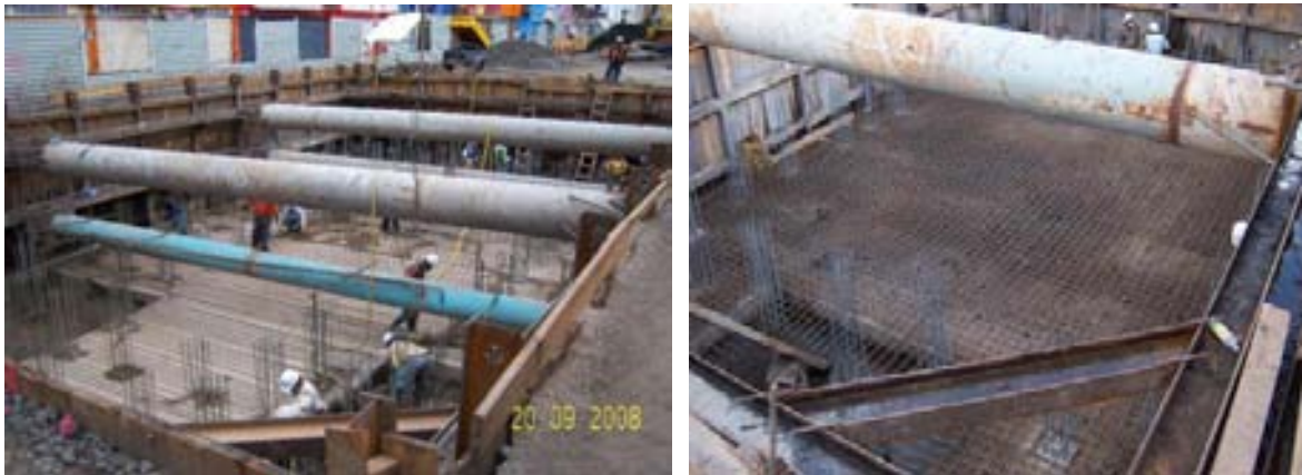
Armado de Losa fondo
