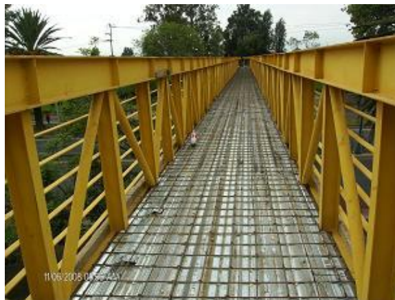
Lámina ROMSA para el sistema de piso del puente
