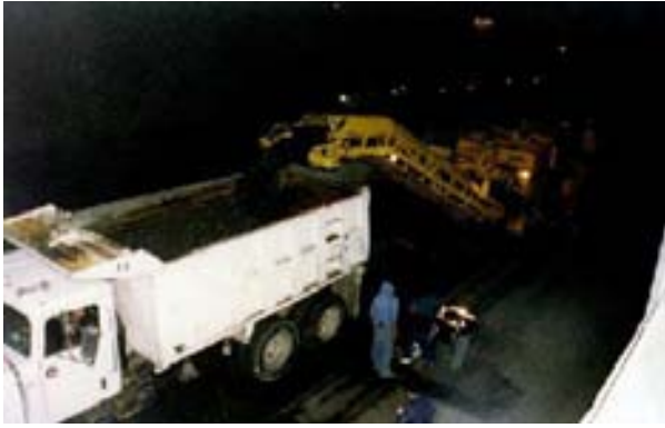
Fresado de carpeta asfáltica vieja
