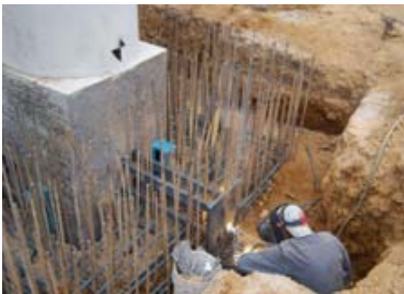
Colocación de pasadores (placas candado)
