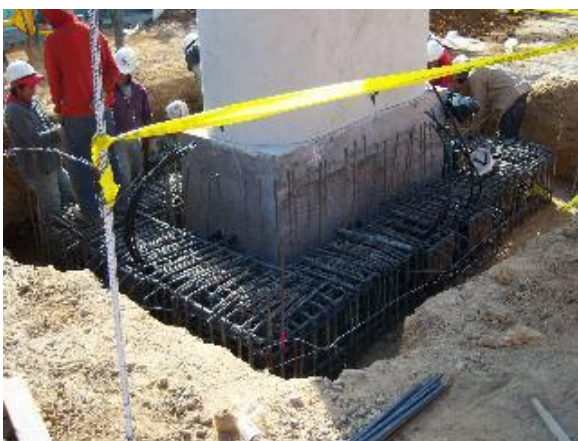
Armado del hombro del candelero (conexión entre la zapata y la columna)
