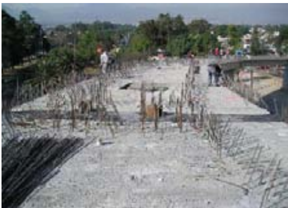
Acero de refuerzo de la trabe que servirá para el anclaje de esta con el firme
