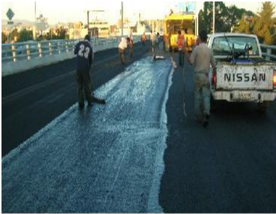
Riego de impregnacion con emulsion cationica RM-2k
