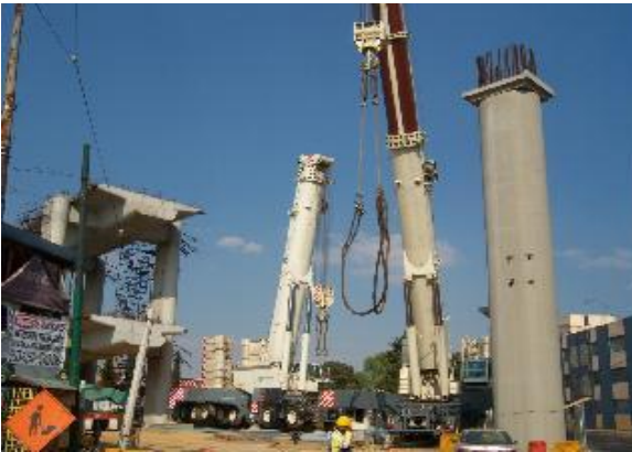
Posicionamiento de las grúas que efectuaran el izaje de la trabe.
