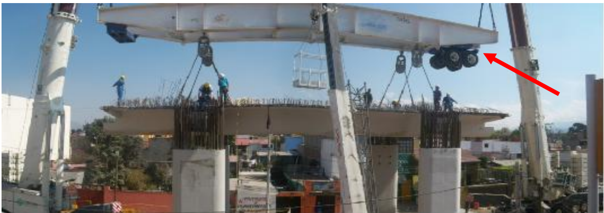
En muchos casos se ocupa un balancín para el montaje de las traves
