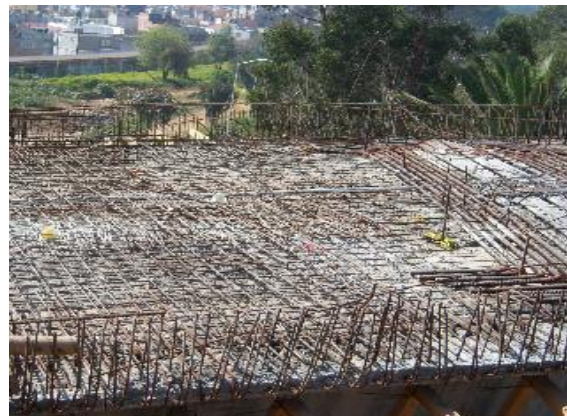
Acero de refuerzo que servirá como anclaje del parapeto de concreto
