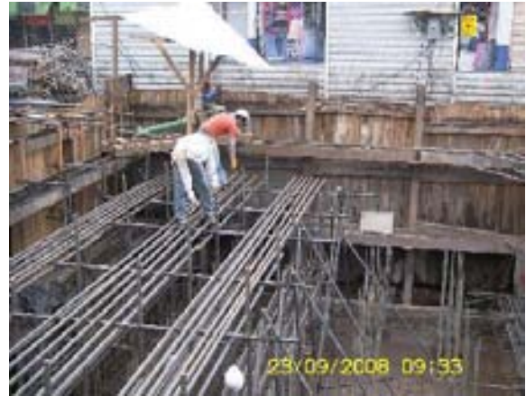
Armado del acero principal longitudinal y transversal con varilla del #12
