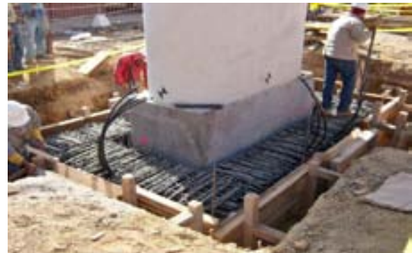
Cimbrado de los hombros de conexión de la zapata
