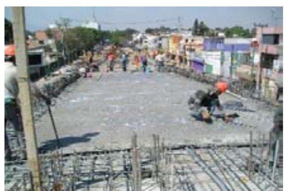
El concreto para el firme de compresión ocupa una resistencia de 300 \text{ kg/cm}^2
