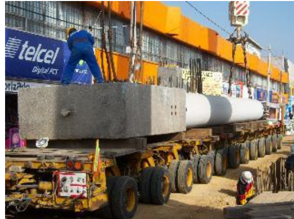
Colocación del tornillo ó perno nivelador dentro del orificio roscado del dado
