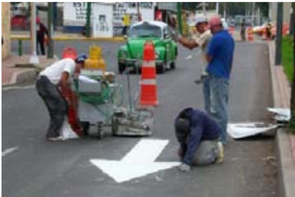
Señalamiento horizontal a nivel bajo puente
