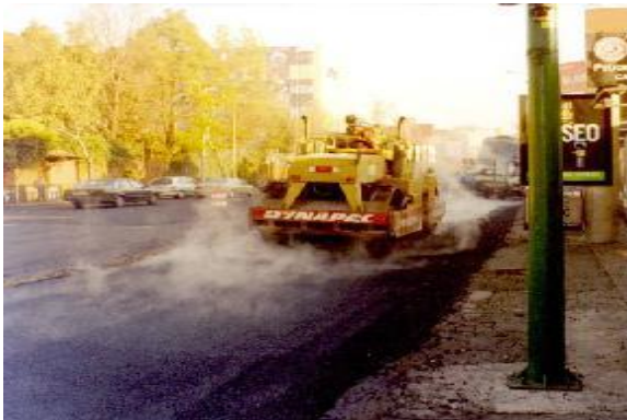
Compactación con plancha de doble rodillo liso
