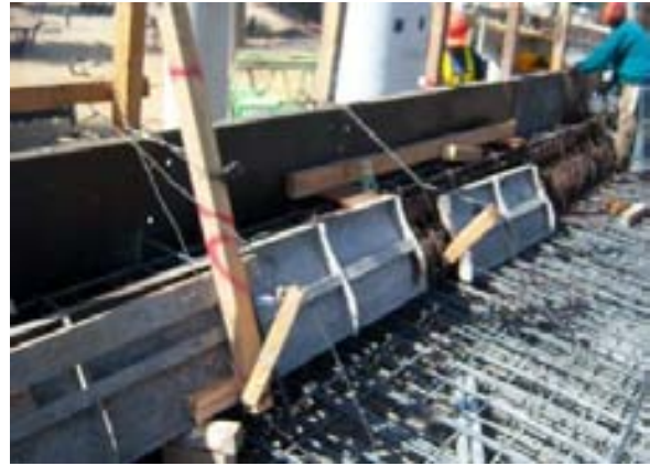
Cimbra metálica del parapeto de concreto
