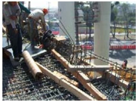
Armado del parapeto metálico con varillas del #6 y del #4
