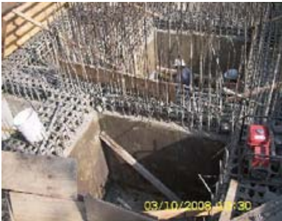
Primera parte del colado de la zapata, hasta el 80% de su altura
