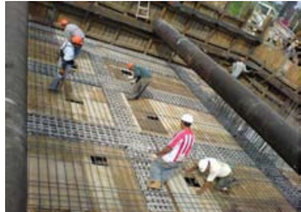
Cimbrado de las celdas de la losa tapa Registros de 60x60cm para recuperar la cimbra.
