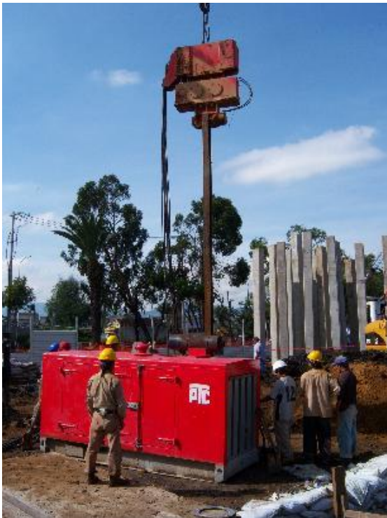
Perforación previa para el hincado de vigas
