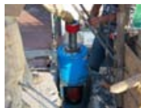
Proceso para aplicar el tensado a los torones
