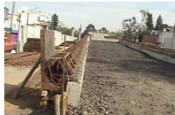
Colocación del relleno aligerado a base de tezontle en greña para formar el terraplén
