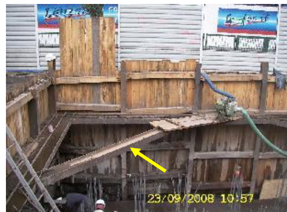
Colocación de las Patas de Gallo con IPR de 10''
