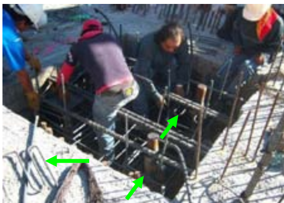
Estribos en forma de gusano para realizar la protección del ducto engargolado y del Torón
