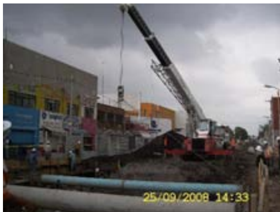
Colocación de Puntales ó Troqueles
