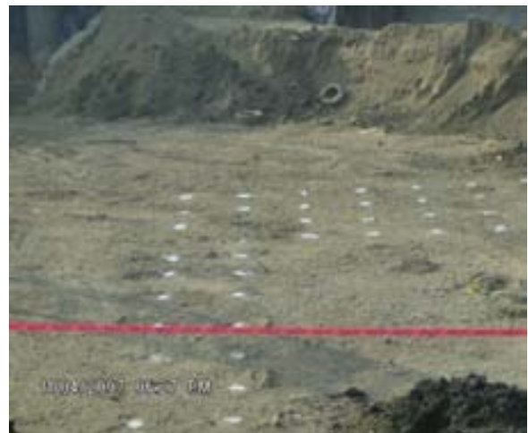
Trazo de la zapata a excavar e infraestructura existente
