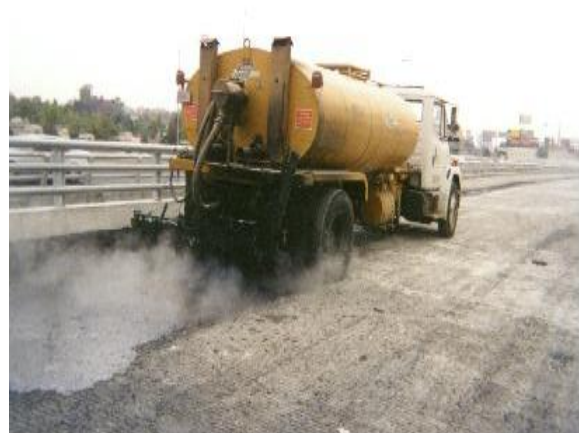
Riego de liga aplicado con la petrolizadora
