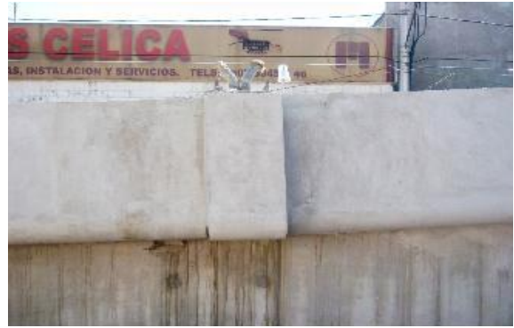
Base sobre el parapeto de concreto para soportar los postes de alumbrado sobre puente
