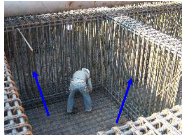
Colocación de estribos con varilla del #4
