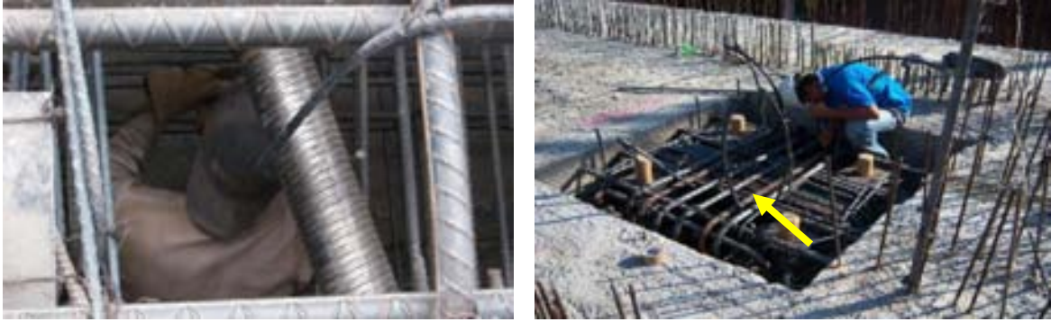
Armado de la conexión trabe-columna, colocando varillas del #10 en forma de U para realizar la grapa
