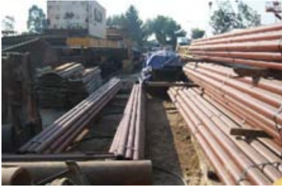
Tubería de 6", 4" y 3" para el parapeto metálico
