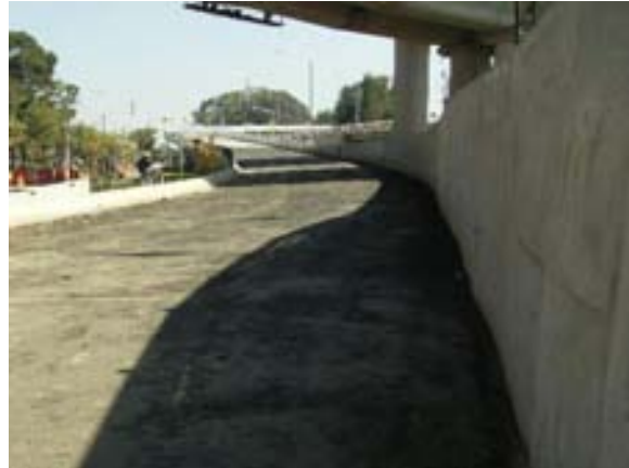
Colocación de la carpeta asfáltica a nivel terraplén
