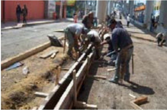
Cimbrado de la guarnición
