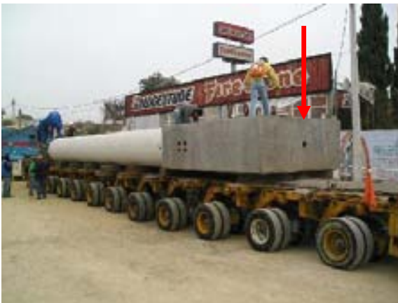
Orificio roscado que se encuentra en la parte inferior del dado de la columna
