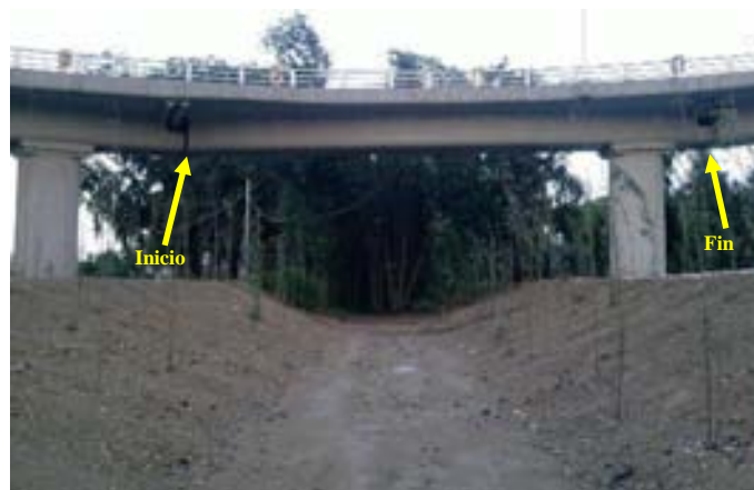
Trabe TCA (Trabe conexión-apoyo)
