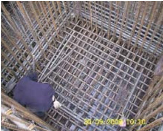
Armado de la Losa Fondo del Candelero con varilla del #6, con dos parrillas
