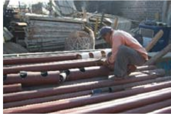
Habilitado del parapeto metálico
