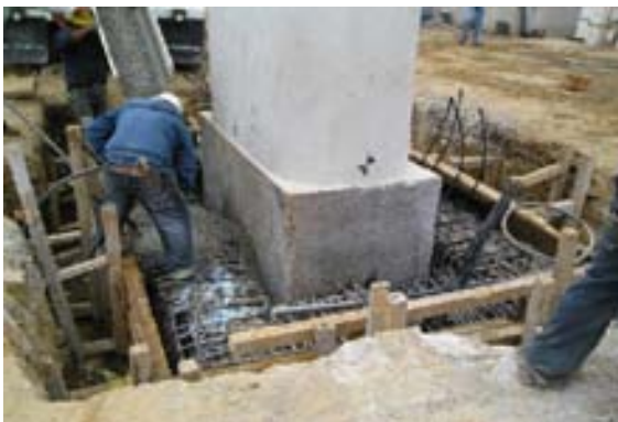
Colado de los hombros de conexión de la zapata
