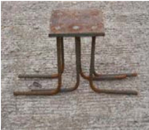
Placa base que ira empotrada en el armado del parapeto de concreto
