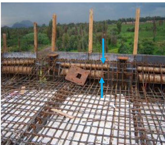
Aligeramiento con tubo de cartón de 6" y 4"
