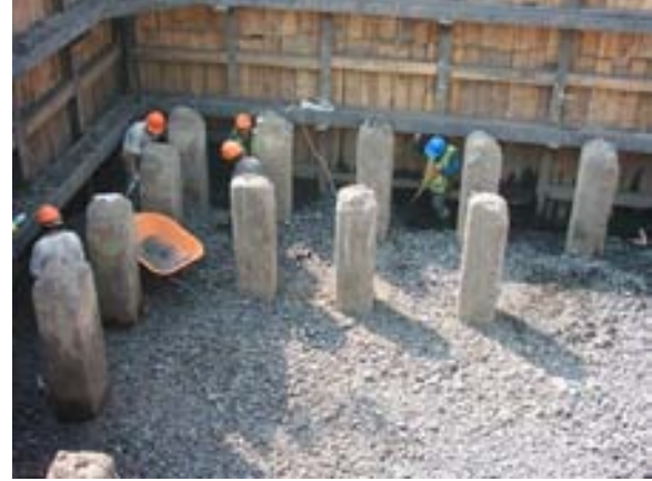
Colocación de la capa rompedora de capilaridad a base de una plantilla de Tezontle en greña acomodado hasta el 95% de su densidad.
