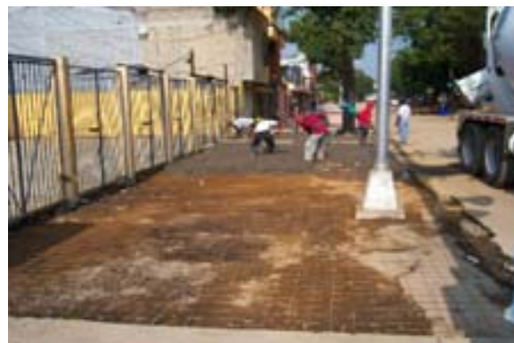
Colado de la banqueta con f'c=200\text{kg/cm}^2
