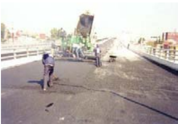
Tendido de carpeta asfáltica, con una cuadrilla de rastrillos para eliminar juntas frías
