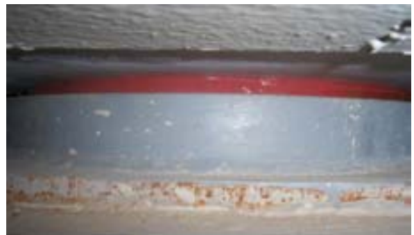
Apoyo fijo tipo encapsulado
