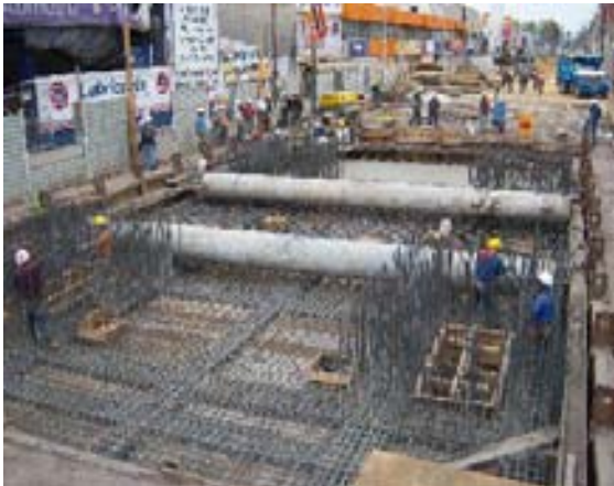
Armado de la losa tapa con varilla del No. 4 a cada 15cm, en dos parrillas
