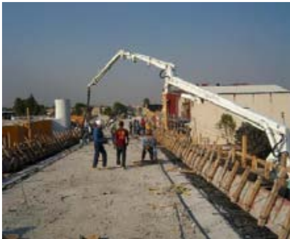
Colado del parapeto de concreto
