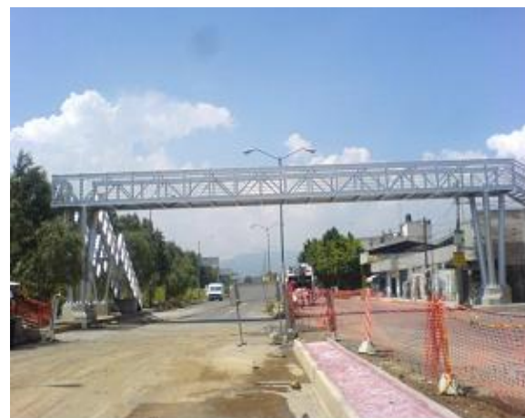
Construcción de puente peatonal ubicado en Av. Muyuguarda
