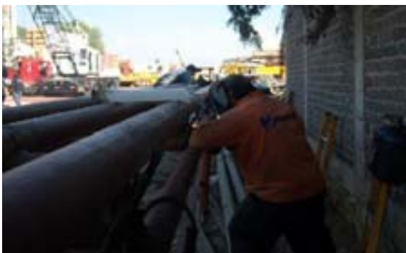
Soldado del parapeto metálico
