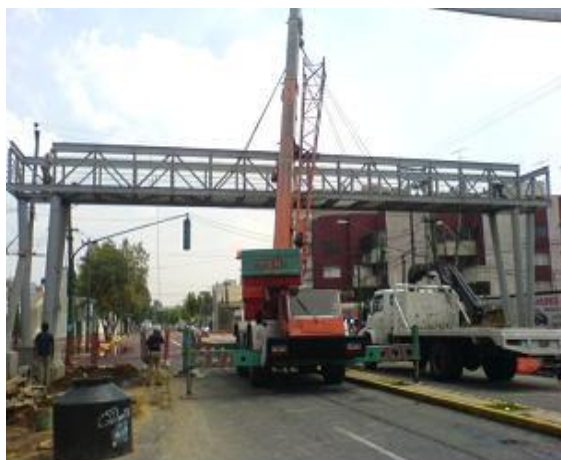
Construcción de puente peatonal ubicado en el Eje 3 Ote
