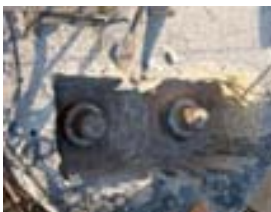
Descimbrado y preparaciones para iniciar el pos tensado de los torones.
