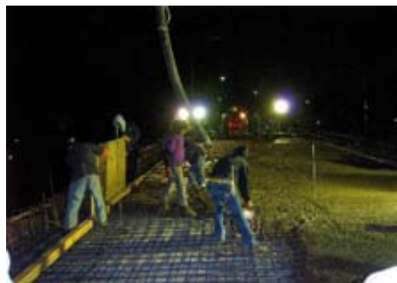
Colado del firme de compresión
