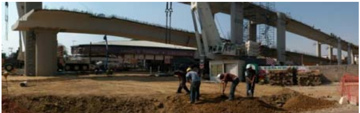
Estabilización del terreno con rellenos compactados
