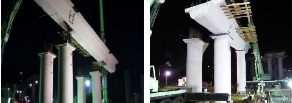
...continuación del izaje de la trabe
