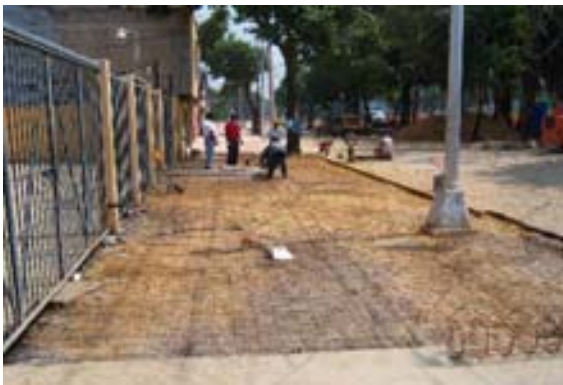
Aplicación de malla metálica
