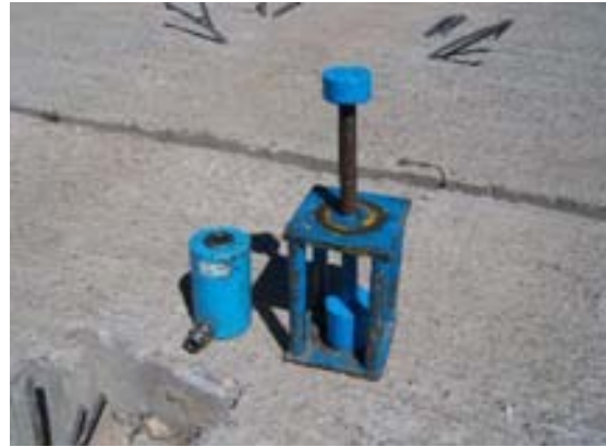
Tensado de los apoyos fijos y móviles
