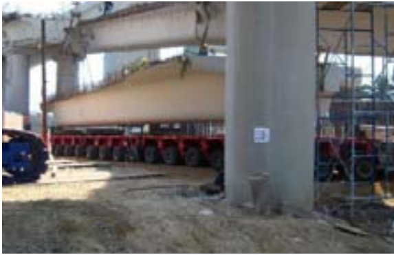
El modular acerca la pieza lo más cerca posible del lugar del montaje
