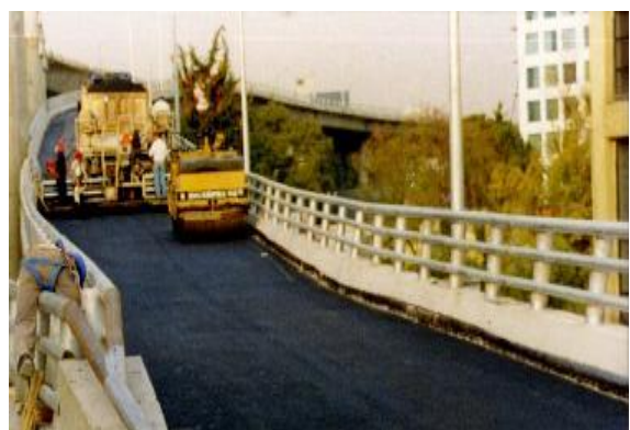
Tendido de carpeta asfáltica, con una cuadrilla de rastrillos para eliminar juntas frías
