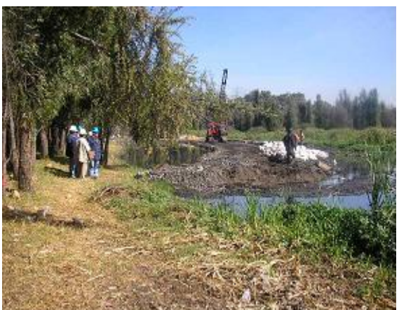
Construcción de terracerías para acceso de maquinaria
