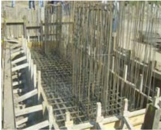
Armado y cimbrado de la zapata del muro estribo
