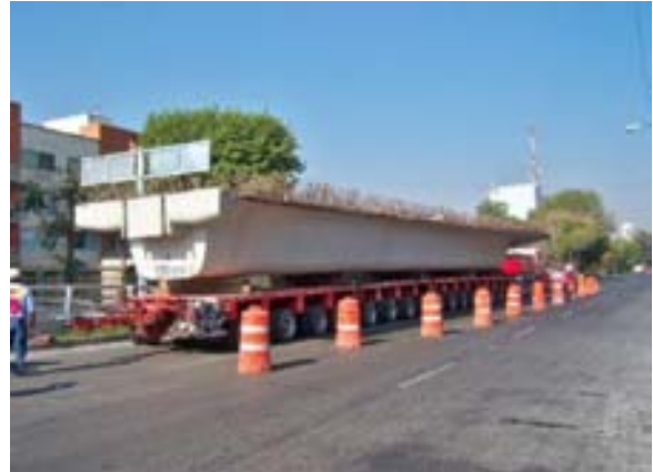
Traslado del elemento prefabricado mediante transporte tipo modular
