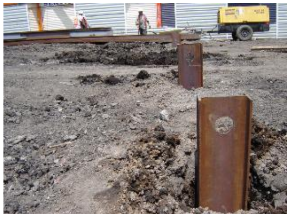
Vigas IPR de 8'' ya hincadas en forma vertical dentro del terreno natural.
