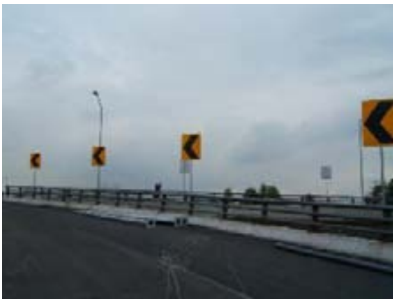
Señalamiento preventivo (película reflejante de color amarillo y leyenda ó filetes con tinta opaca).
