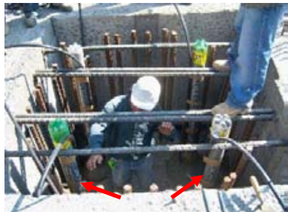
Colocación de ductos engargolados para protección del Torón
