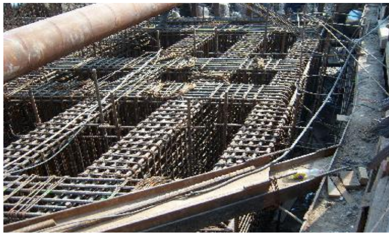
Armado de contratrabes terminado al 100%
