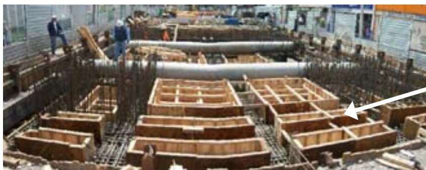
Cimbra colocada al 100%
