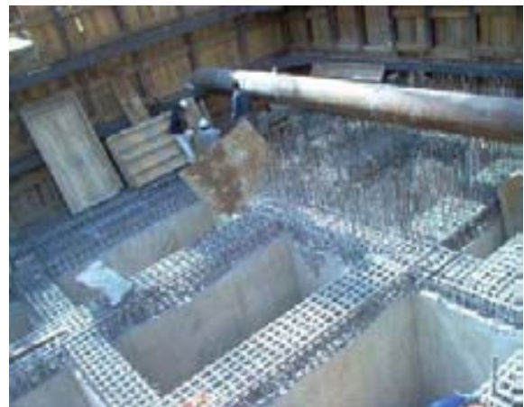
Primera parte del colado de la zapata, hasta el 80% de su altura
