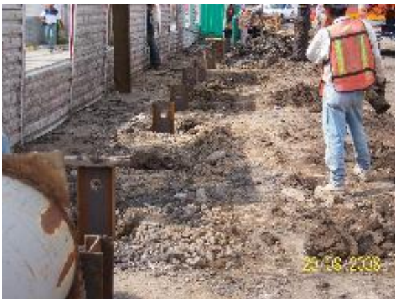
Vigas IPR de 8'' ya hincadas en forma vertical dentro del terreno natural.
