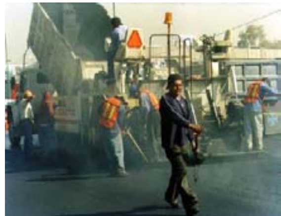
Tendido de carpeta asfáltica sobre puente
