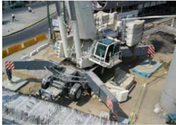
Posicionamiento de las grúas que efectuaran el izaje de la trabe.
