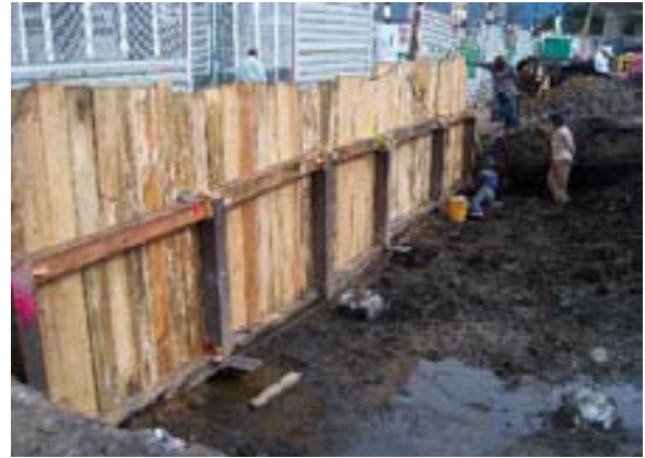
Colocación de tablones en todo lo ancho y largo de la excavación
