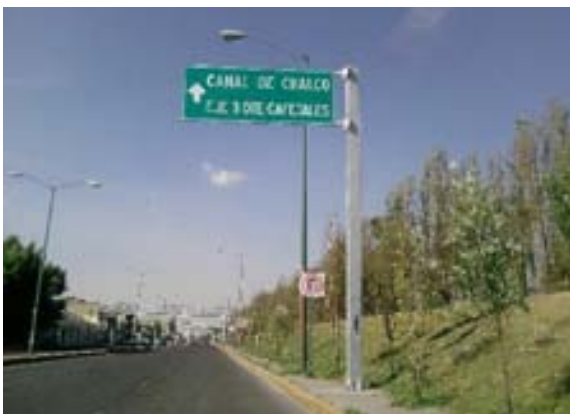
Señalamiento informativo (película reflejante de color verde y la leyenda ó filete con tinta color blanco)
