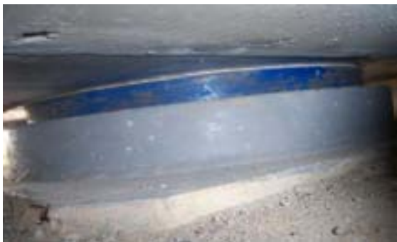
Apoyo móvil tipo encapsulado
