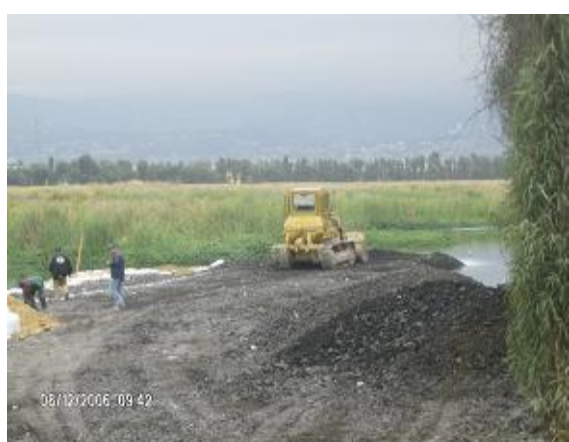
Construcción de terracerías para acceso de maquinaria
