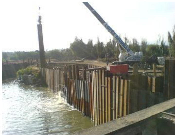
Colocación de machimbrado
