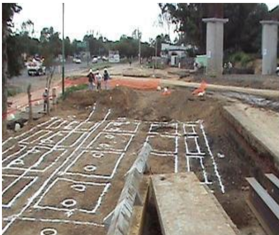
Trazo de la zapata a excavar e infraestructura existente
