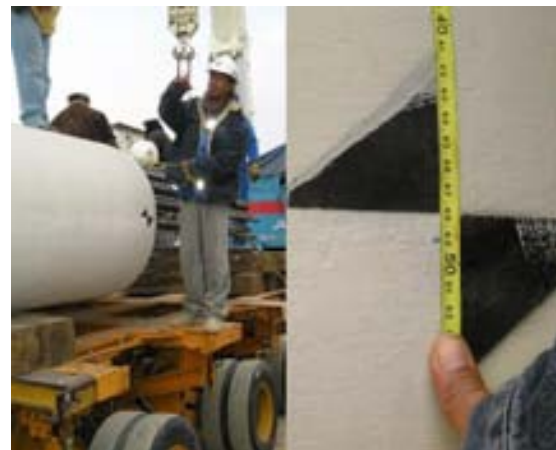
Colocación de las palomas de nivel topográfico y ejes de referencia
