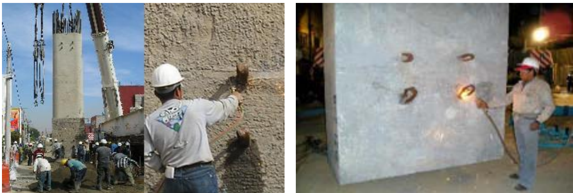
Corte de ganchos de izaje de la columna con equipo de oxicorte
