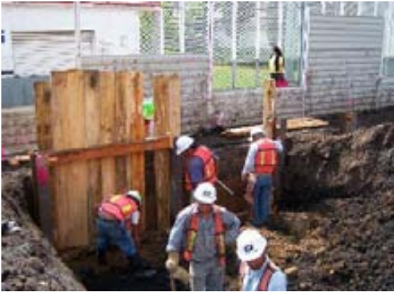
Colocación de tablones en todo lo ancho y largo de la excavación
