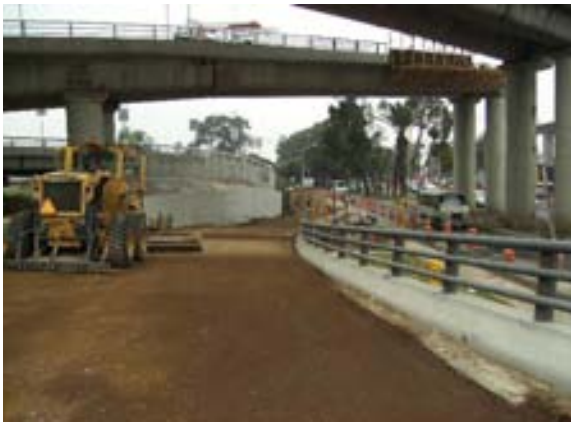
Compactación de la Base hasta el 100% de su Peso Volumétrico Seco Máximo (P.V.S.M.)
