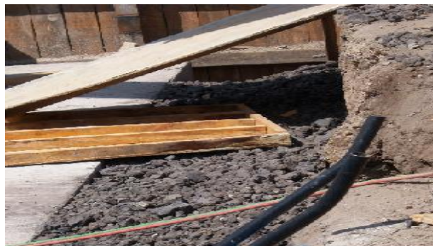
Relleno de la zapata en todo el perímetro con material de tezontle
