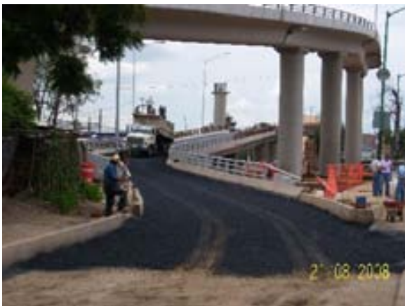
Manteo con material de mezcla asfáltica
