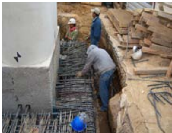
Armado del hombro del candelero (conexión entre la zapata y la columna)
