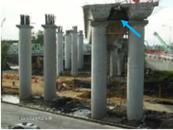
Armado del cabezal que conecta estructuralmente a dos traves tipo TA6
