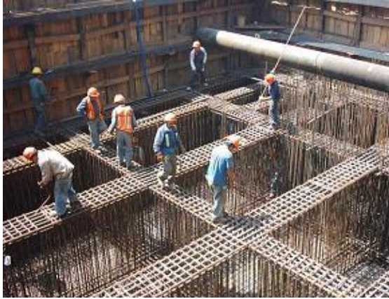
Colocación del acero de temperatura dentro de las contratrabes con varilla del #4
