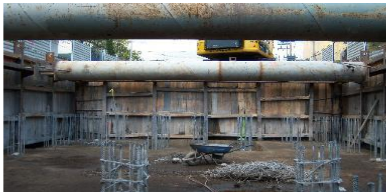
Acero que pertenecía al alma del pilote que servirá para realizar la conexión entre la cimentación profunda y la cimentación superficial.
