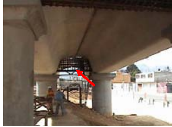
Armado del cabezal que conecta estructuralmente a dos traves tipo TA6
