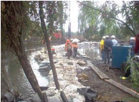
Confinamiento del área mediante costaleras
