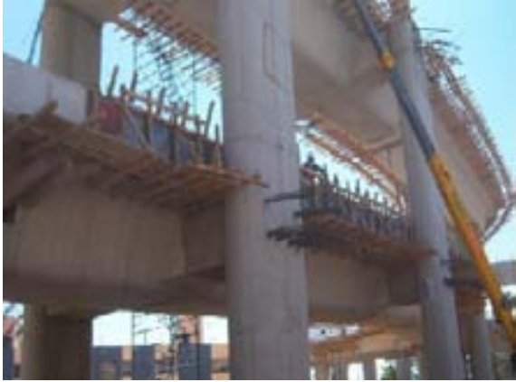
Colocación de obra falsa
