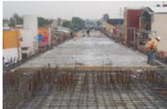
Colado del firme de compresión
