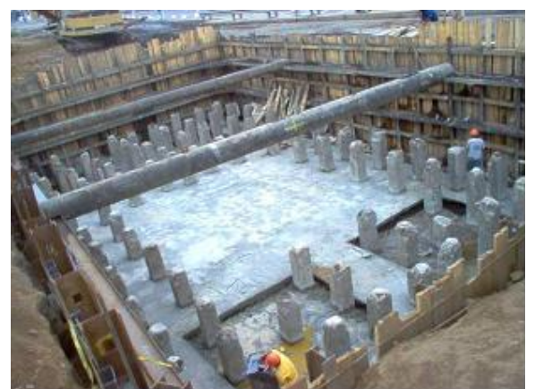
Colado de la plantilla de concreto simple en toda el área de la zapata.
