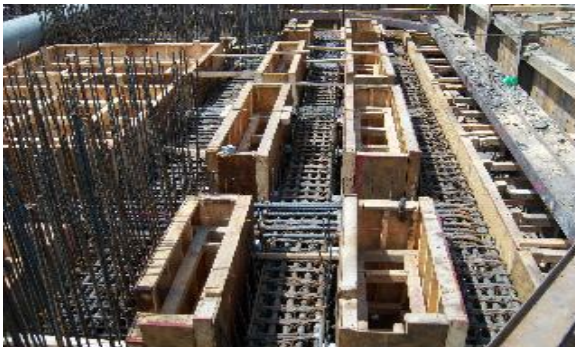
Cimbrado de las contratrabes exteriores
