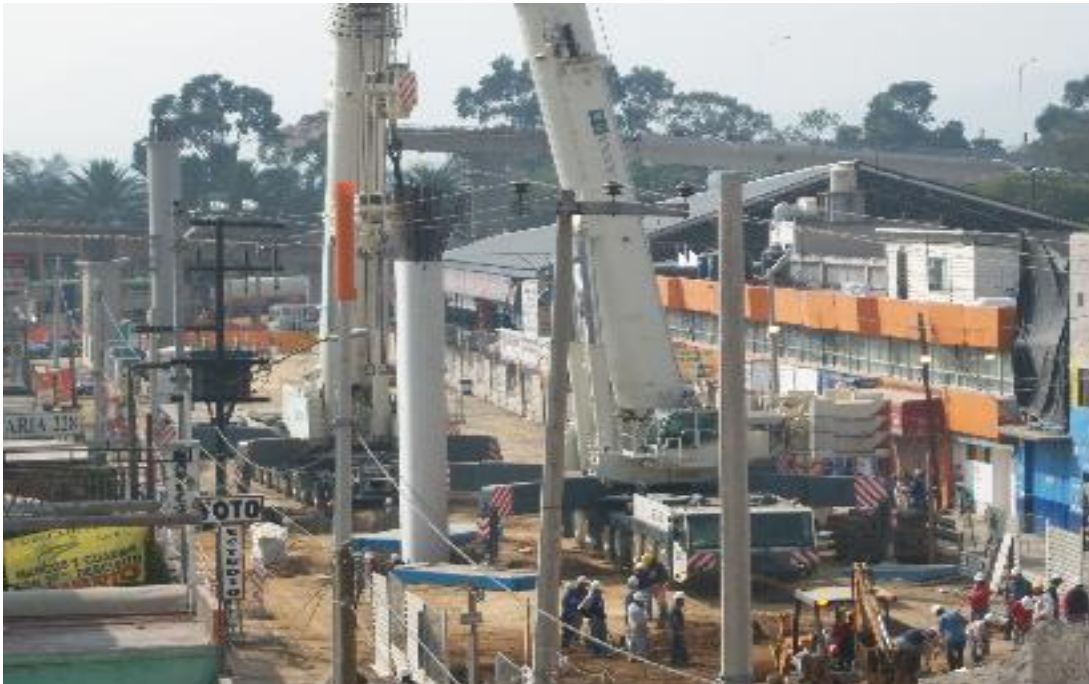
En esta foto se muestran las interferencias u obstáculos que tienen que librar las grúas y la columna al momento de efectuar el montaje. (En este caso se observan los postes de alumbrado público y las edificaciones.)
