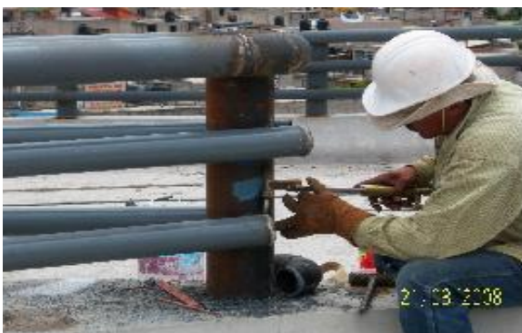
Aplicación de soldadura para unir tramos de parapeto metálico
