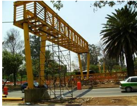
Construcción de puente peatonal ubicado en anillo periférico
