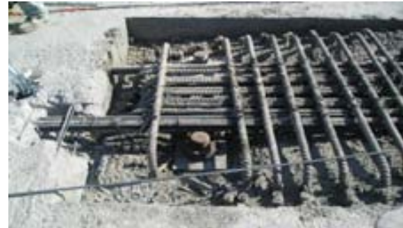
Descimbrado y preparaciones para iniciar el pos tensado de los torones.
