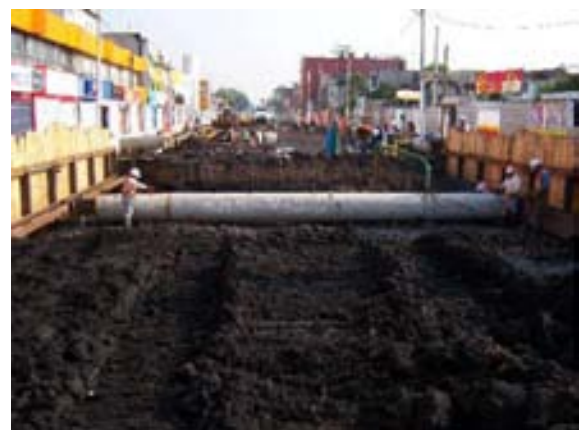
Colocación de Puntales ó Troqueles
