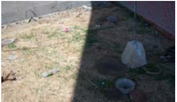
Sistema de tierras a base de un tubo de concreto de 20cm de diámetro que aloja a la varilla
