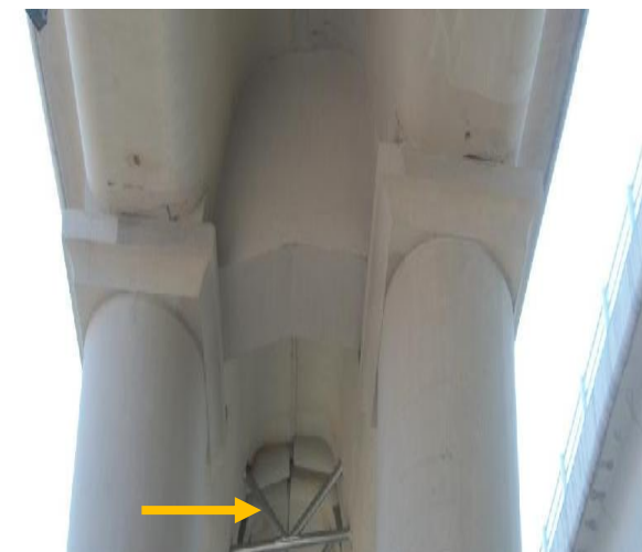
Diafragmas metálicos con tubería de diámetro de 4"
