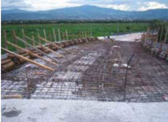
Unicel que se usa de aligeramiento para firmes de compresión con espesores mayores a 30cm
