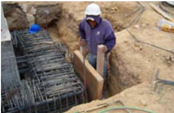
Cimbrado de los hombros de conexión de la zapata
