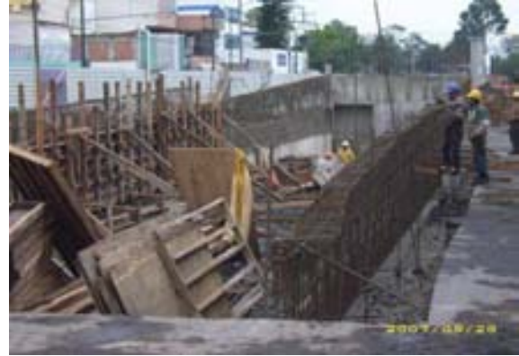
Armado y cimbrado de los muros de contención
