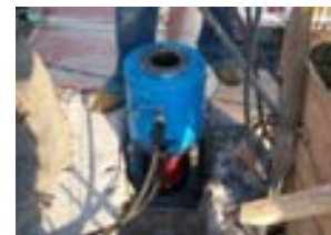
Descimbrado y preparaciones para iniciar el pos tensado de los torones.
