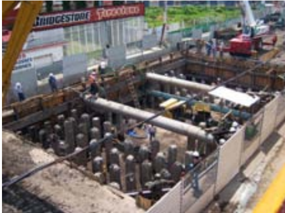
Colocación del segundo nivel de Troqueles ó Puntales
