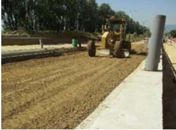
Colocación de la Base
