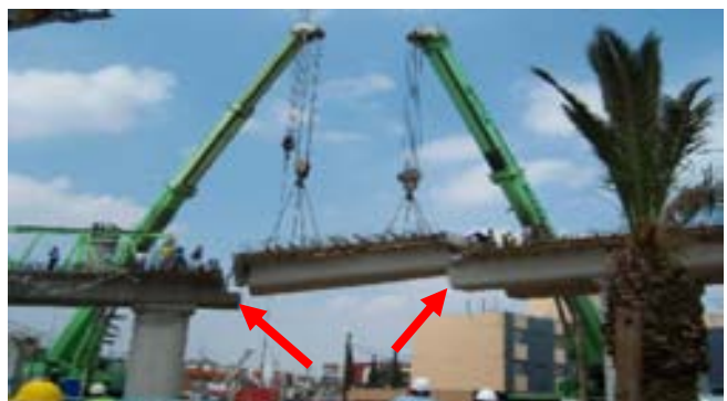
Ubicación de los apoyos móviles ó fijos según sea el caso
