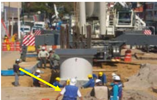
Descenso de la columna hasta el fondo del candelero y colocación de las cuñas estabilizadoras metálicas
