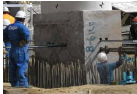
Colocación de las varillas de conexión dentro de los pasos ó ductos de conexión
