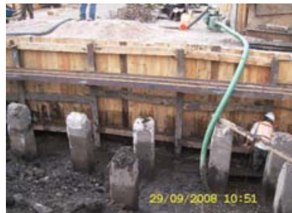
Bombeo de achique para resolver la inundación de las zapatas
