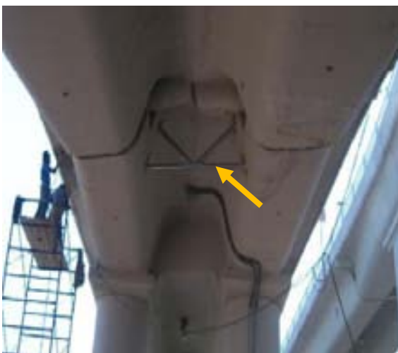
Diafragmas metálicos con tubería de diámetro de 4"
