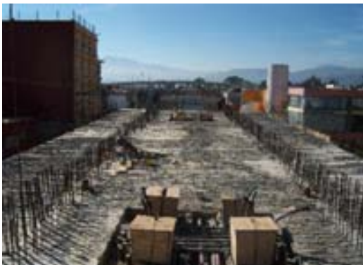
Cimbrado sobre las 4 placas de acero
