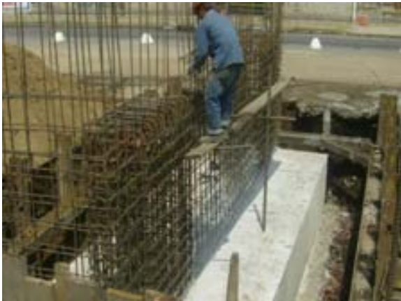
Armado del muro estribo con varilla del #4
