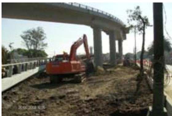
Colocación de la Sub-Base
