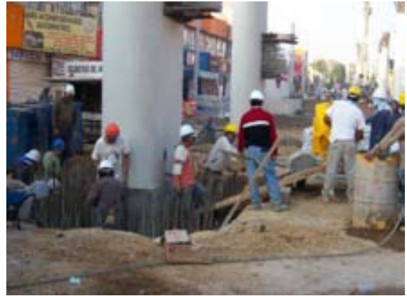
Colado del Grout para rellenar los espacios que existen entre el dado de la columna y las paredes del candelero.
