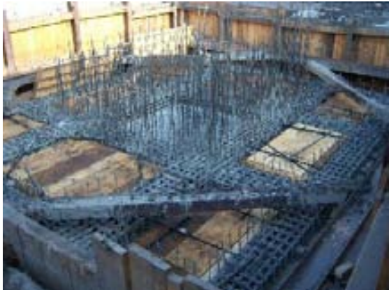
Cimbrado de las celdas de la losa tapa Registros de 60x60cm para recuperar la cimbra.
