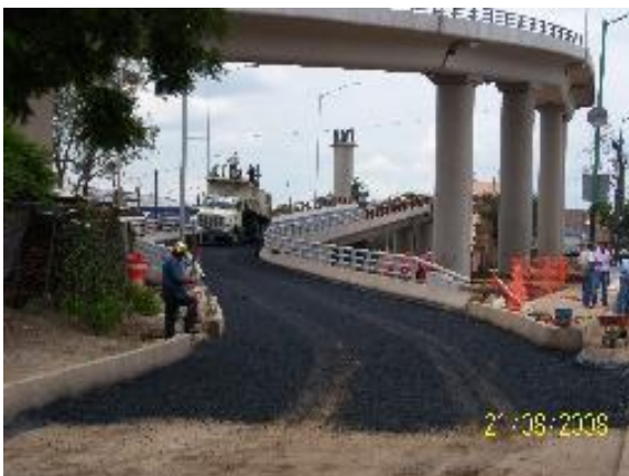
Colocación de la carpeta asfáltica a nivel terraplén
