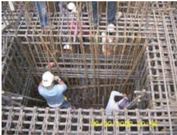
Colocación de estribos con varilla del #4
