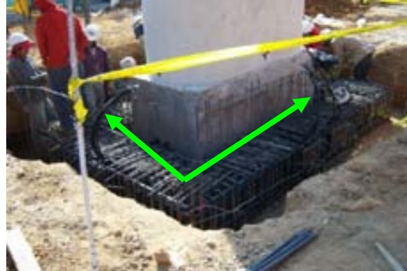
Colocación de las mangueras en los ductos de conexión de la columna-zapata
