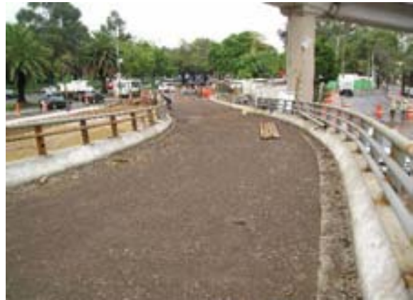
Compactación de la Base hasta el 100% de su Peso Volumétrico Seco Máximo (P.V.S.M.)
