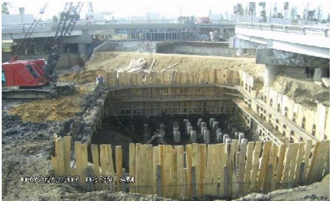
El tablestacado finalmente se colocó en las cuatro caras, llegando hasta la profundidad de desplante de la zapata
