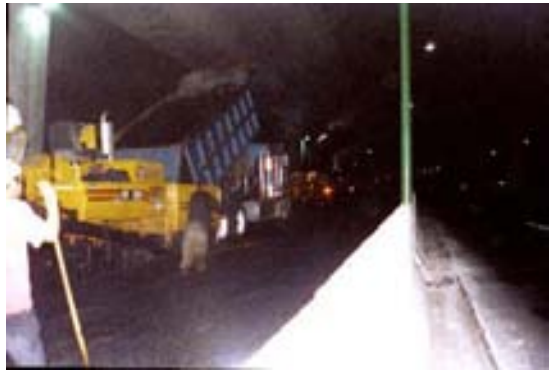
Tendido de carpeta asfáltica bajo puente
