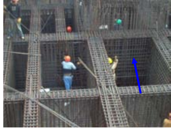
Colocación del acero de temperatura dentro de las contratrabes con varilla del #4
