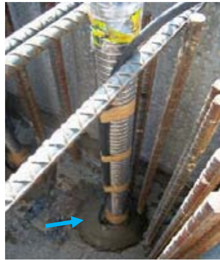
Grout en el perímetro de la trompeta para garantizar el sello de la misma
