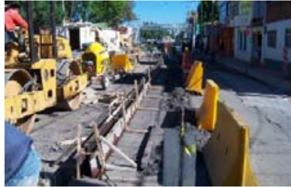
Cimbrado de la guarnición
