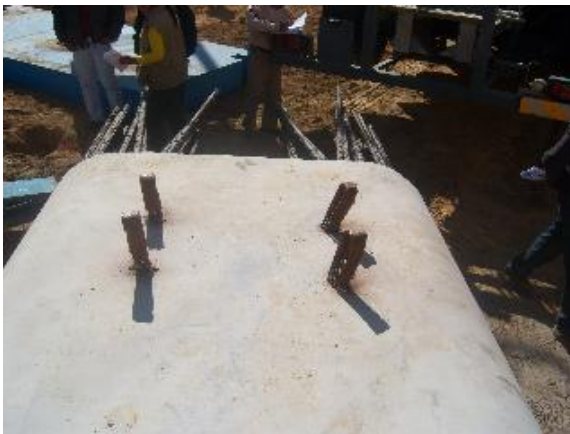
Ganchos de izaje de la columna
