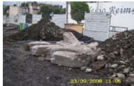
Fragmentos de concreto procedentes de la demolición de pilotes.
