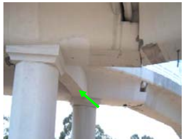
Cabezal ya colado
