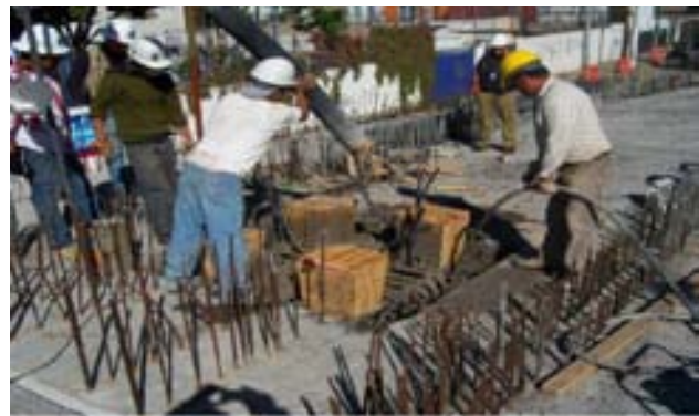
Colado de la conexión con una f'c=450\text{kg/cm}^2
