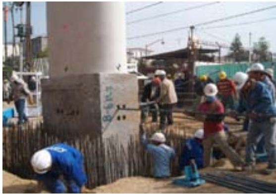
Colocación de las varillas de conexión dentro de los pasos ó ductos de conexión
