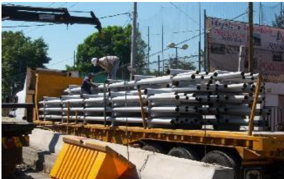
Transporte del parapeto metálico
