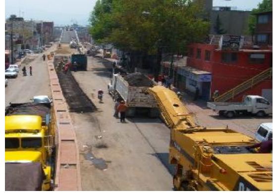
Fresado de carpeta asfáltica vieja
