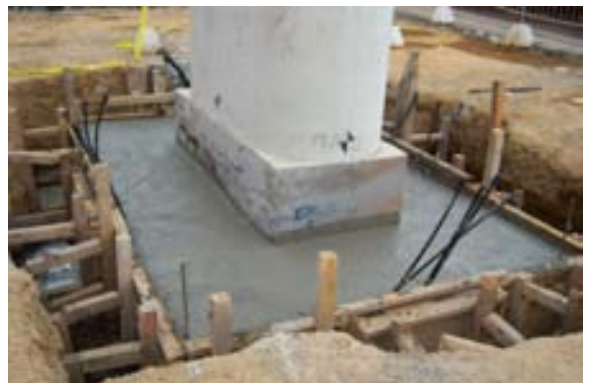
Colado de los hombros de conexión de la zapata
