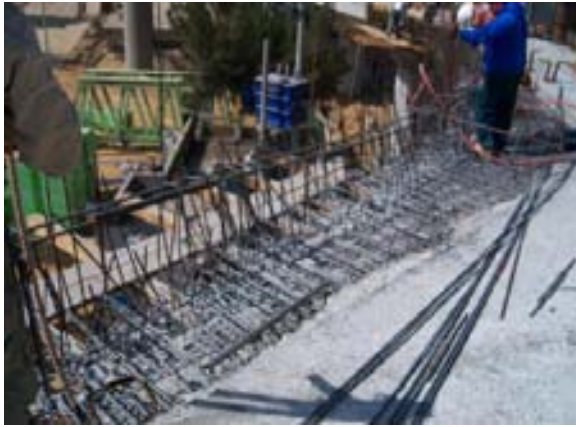
Armado del parapeto metálico con varillas del #6 y del #4
