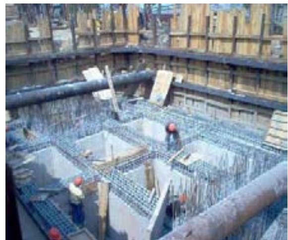
Se procedió a realizar el descimbrado de las contratraves sin maltratar dichos elementos.
