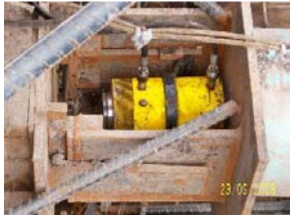
Colocación del segundo nivel de Troqueles ó Puntales
