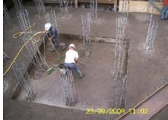
Limpieza de la zapata para empezar con el armado de la losa fondo
