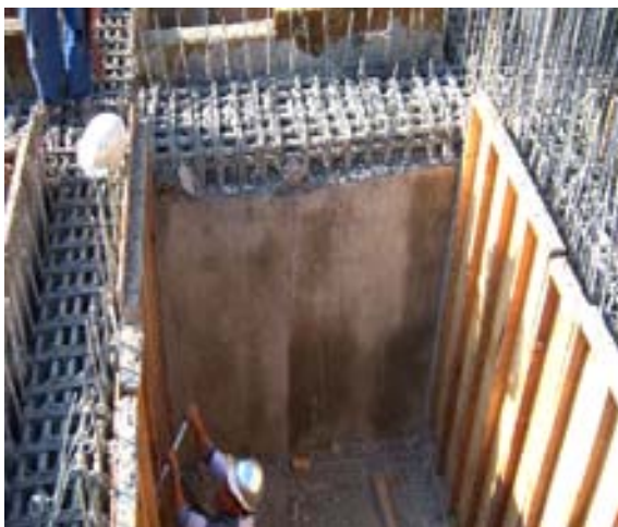
Se procedió a realizar el descimbrado de las contratraves sin maltratar dichos elementos.
