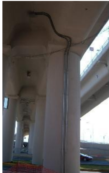
Sistema de tierras a base de un tubo de concreto de 20cm de diámetro que aloja a la varilla
