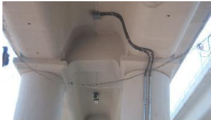
Sistema de tierras a base de un tubo de concreto de 20cm de diámetro que aloja a la varilla
