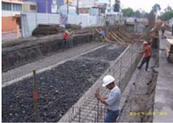
Armado de los muros de contención
