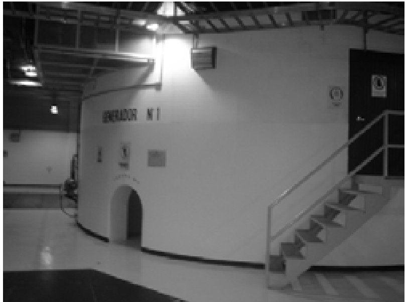
Figura. 3.16 Generador síncrono.
