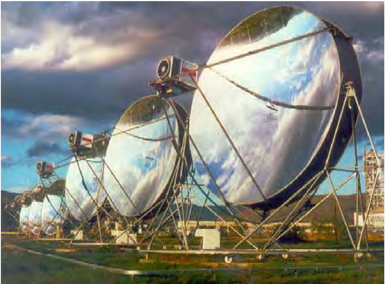
Figura. 1.28 Colectores de punto parabólico en Almería España con una capacidad de 10 MW.
