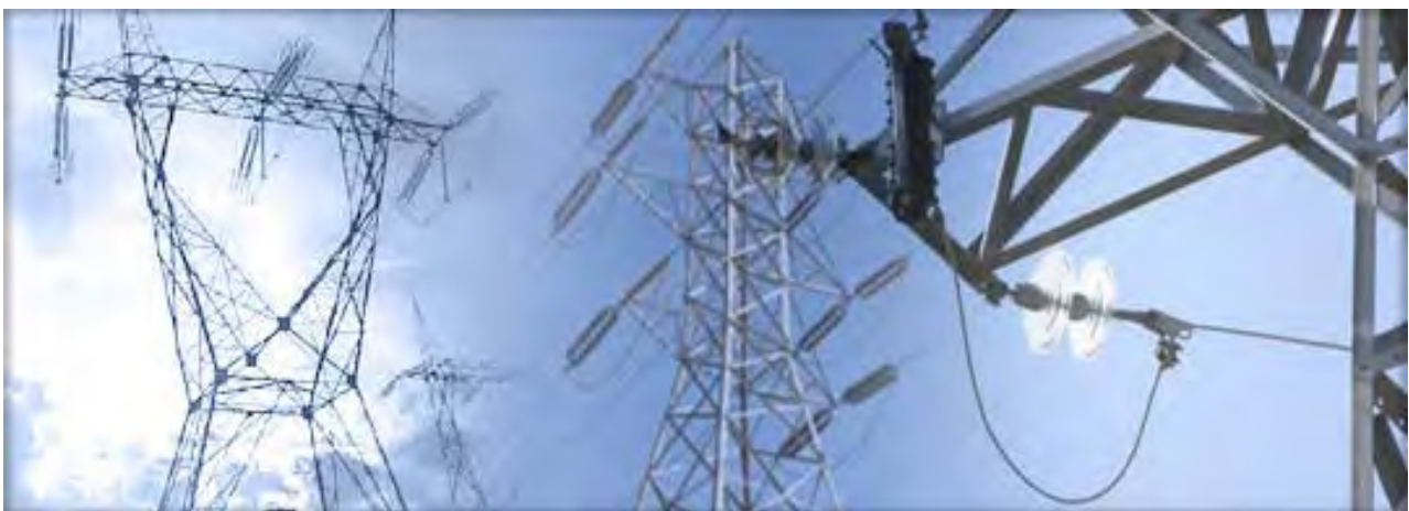
Figura. 5.3 Líneas de transmisión.
