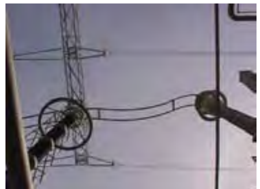
Figura. 3.28 Conexión entre Apartarrayos de óxido de metal (izquierda) y bushing del autotransformador (derecha).
