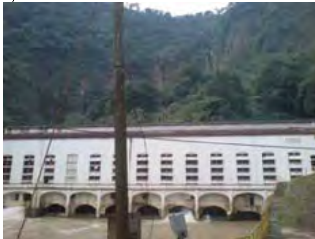
Figura. 1.12 Planta Hidroeléctrica Necaxa.
